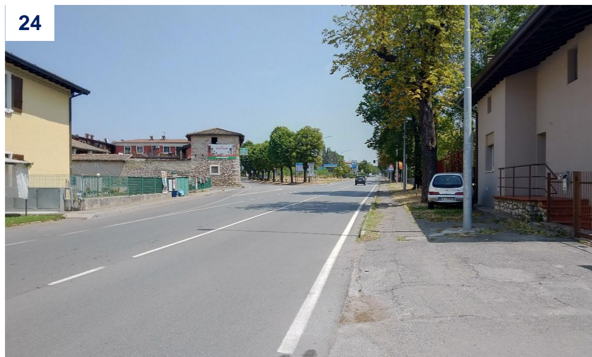
Figura 1-27: vista da via Molini verso est. Su tale strada è previsto il passaggio del cavo interrato.
