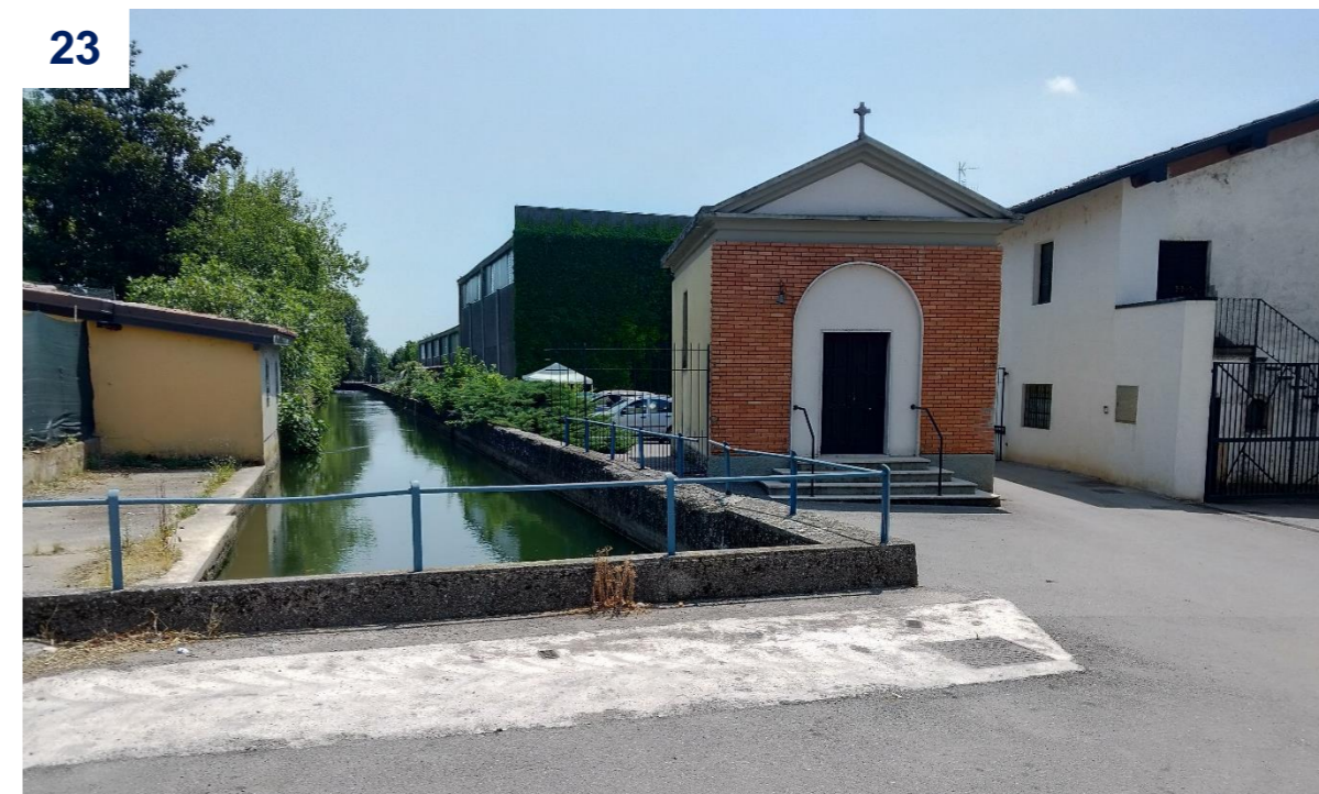
Figura 1-26: vista della Sertola Lonata da via Molini. È previsto l'attraversamento di tale roggia da parte del cavo interrato.
