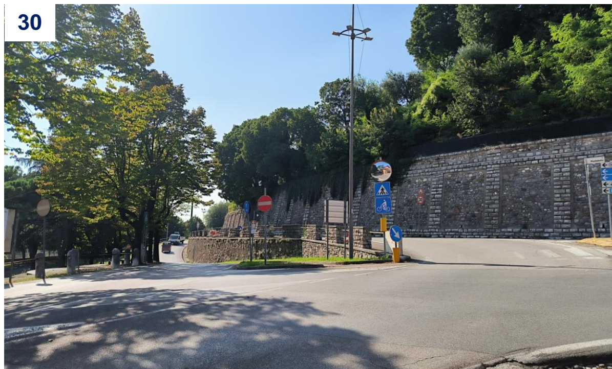
Figura 1-33 vista di via Montebello verso ovest, dall'incrocio con via IV novembre. L'area ricade tra quelle tutelate ai sensi dell'art. 136 del D.Lgs 42/2004.
