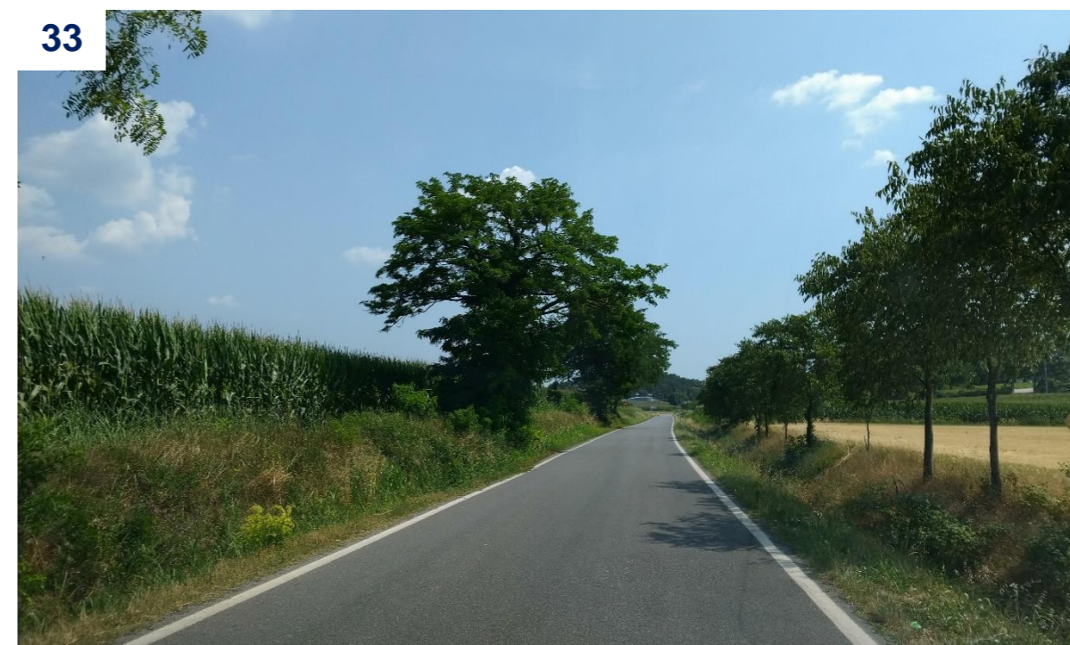
Figura 1-36: vista di via Brodena verso sud.
