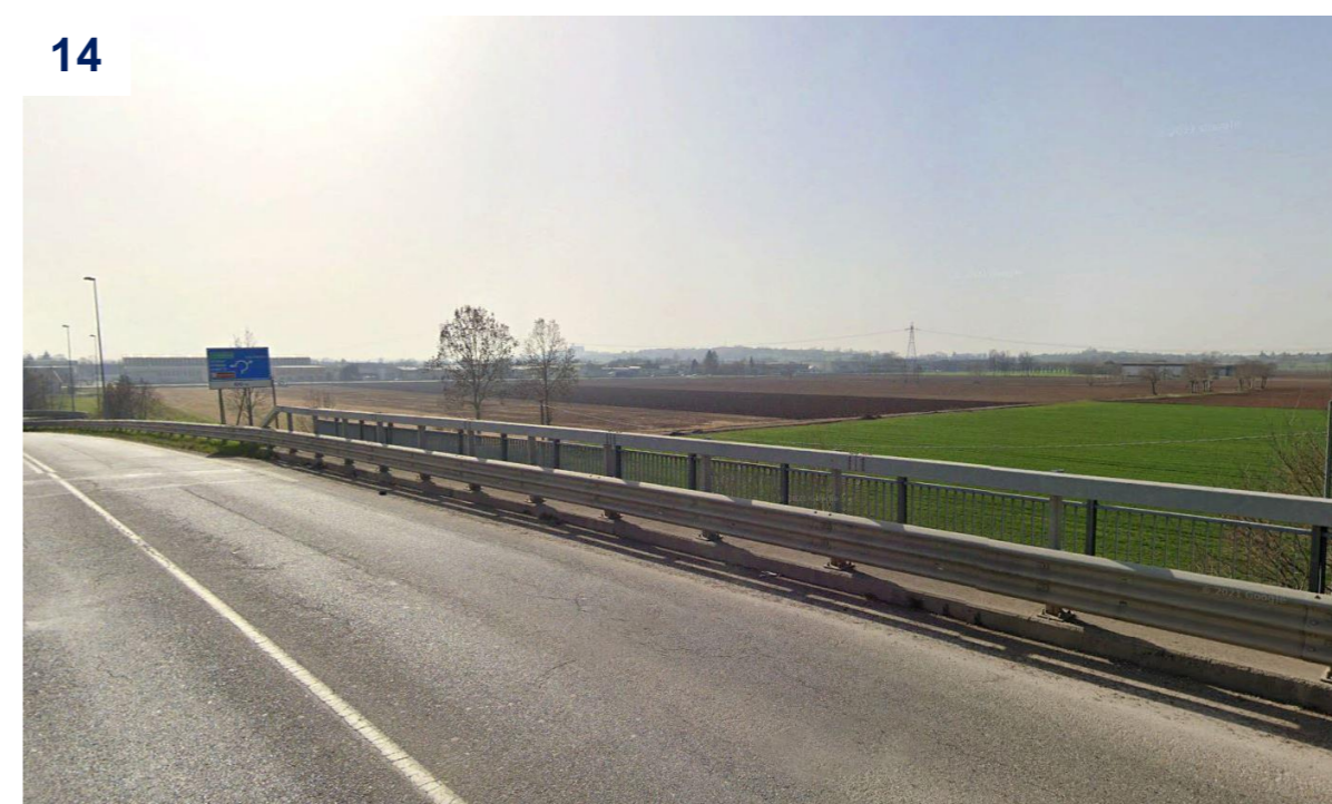
Figura 1-15: vista verso SW dal cavalcavia della SP28 dell'area di intervento posta nel territorio di Bedizzole. In particolare l'area di interesse è quella sottoposte a lavorazioni, mentre la fascia che guarda verso la SP11 non verrà interessata.
