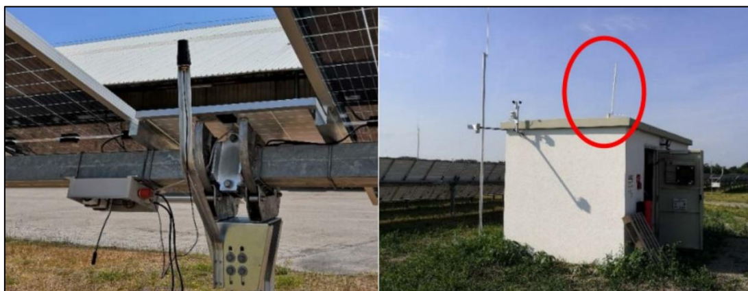
Figura 5-6: esempio di collegamento - L'antenna TP sul tracker (a sinistra) e l'antenna del RP nella parte superiore della stazione di trasformazione (a destra).
