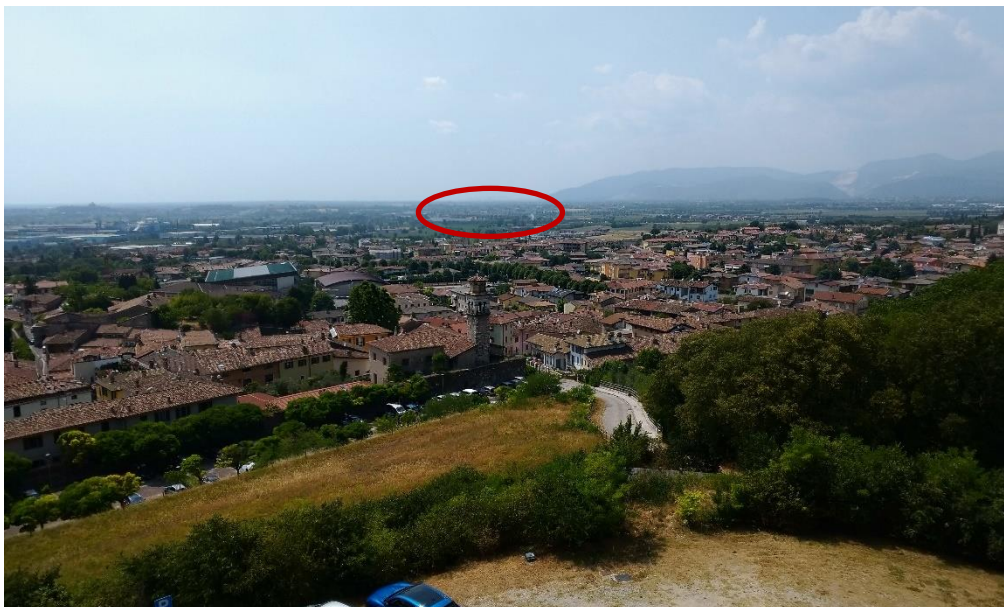
Figura 11-2: vista del contesto paesaggistico dal castello di Lonato. In rosso è evidenziata l'area in cui verrà realizzato il progetto dell'agrivoltaico.
