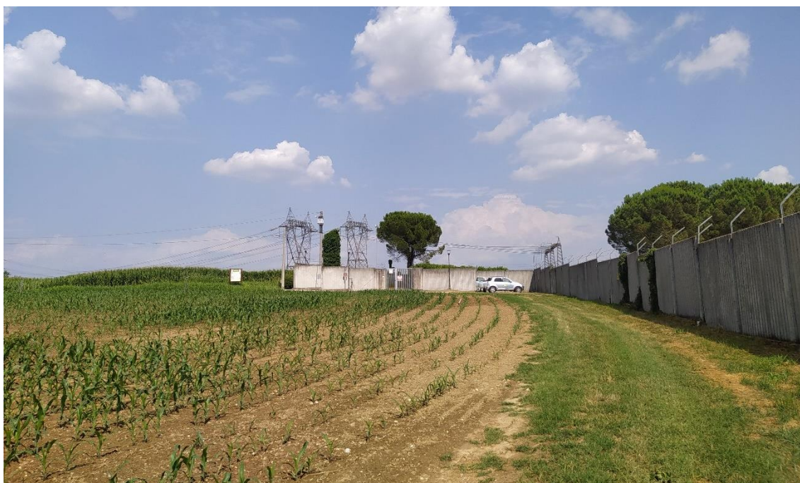
Figura 9-2: sito in cui è prevista la localizzazione della nuova sottostazione elettrica. Sullo sfondo l'accesso al sito della fornace che appare completamente circondato dal muto perimetrale della stazione elettrica esistente.
