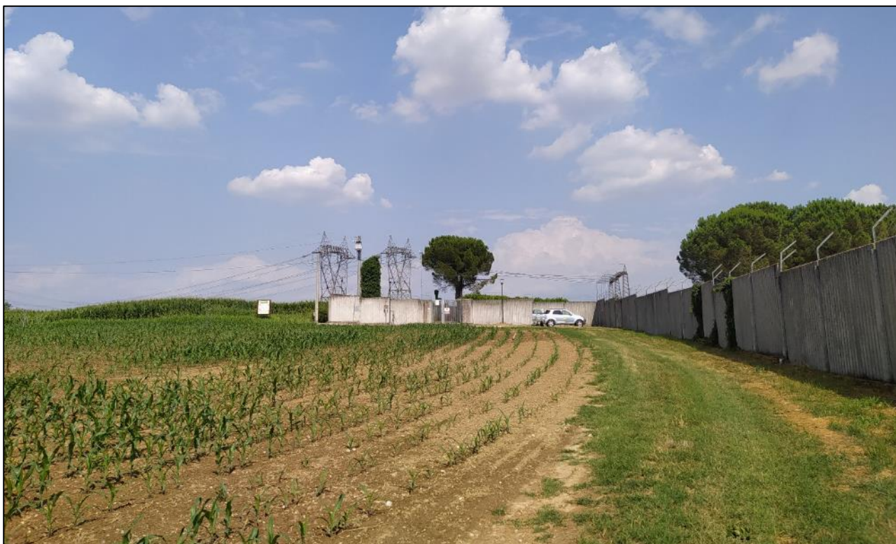
Figura 6.81: Sullo sfondo l'accesso al sito della fornace che appare completamente circondato dal muto perimetrale della stazione elettrica esistente.
