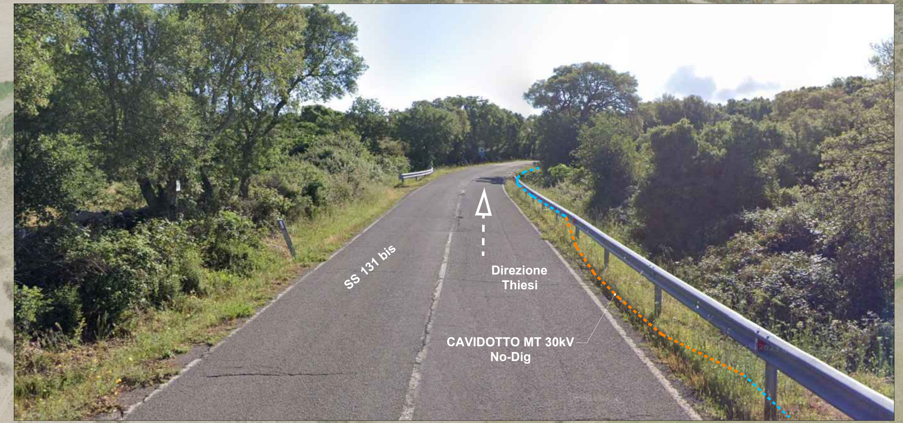
FOTO 4 - SUPERAMENTO INTERFERENZA - VISTA DA TERRA
