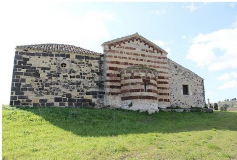
Ploaghe, chiesa di Sant'Antonio abate di Salvenor. Prospetto posteriore (foto di repertorio, open source )
