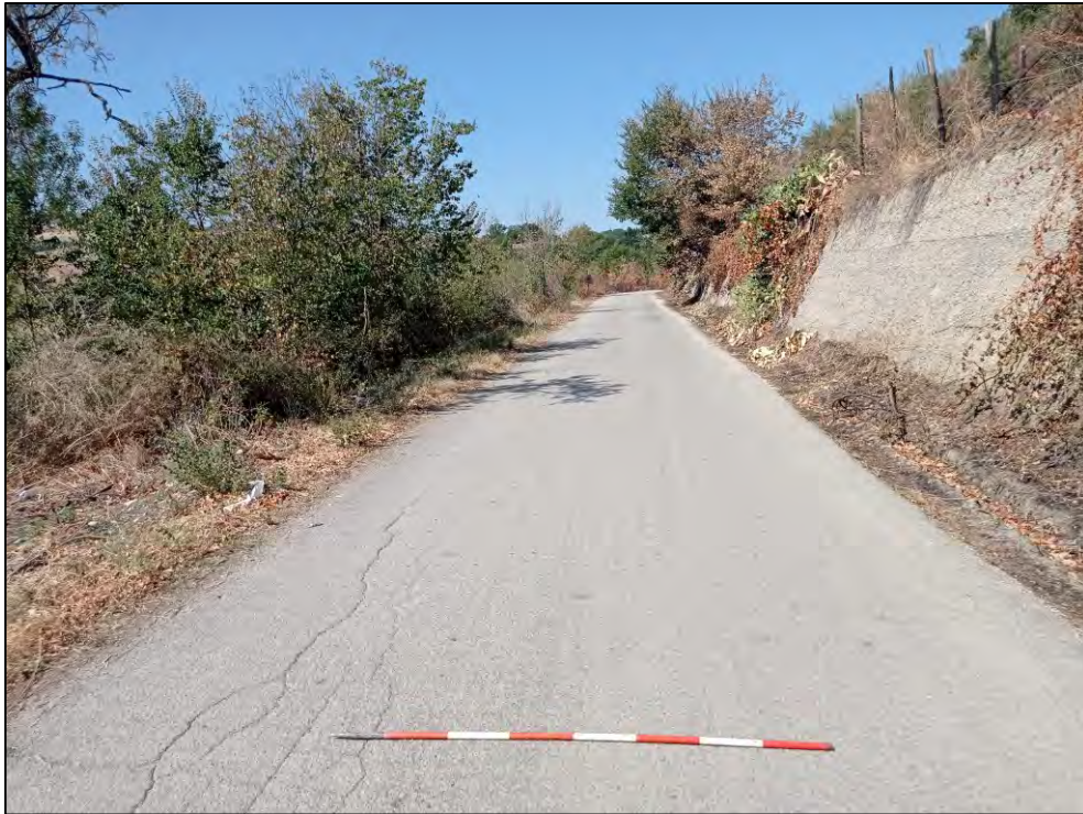
Fig. 25: cavidotto - Strada Guardiola oltre il tratturo Centurelle-Montesecc
