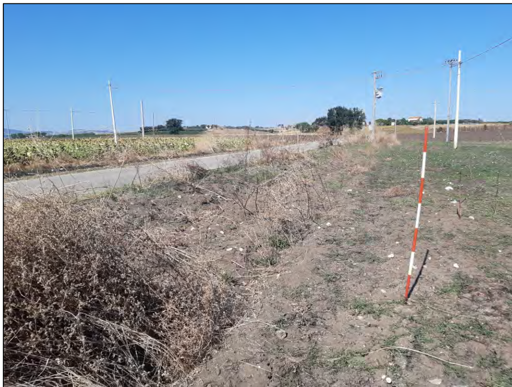
Fig. 38: cavidotto – SP 124. Tratto in corrispondenza delle UUTT 6-7
