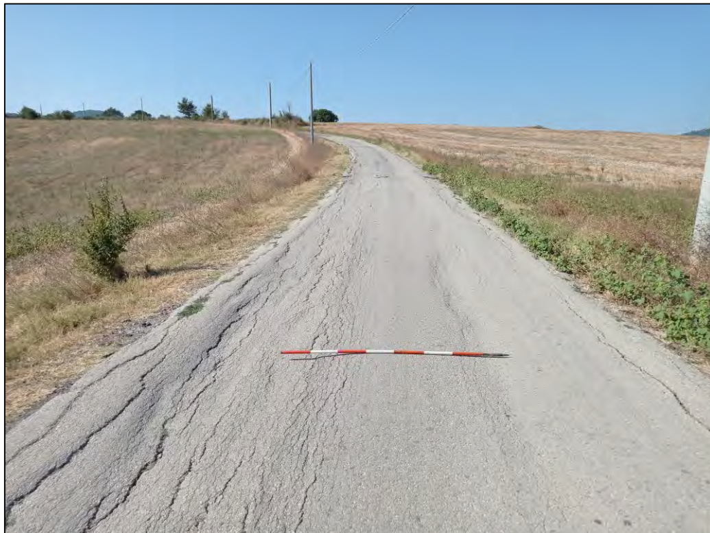
Fig. 22: cavidotto – Strada Guardiola
