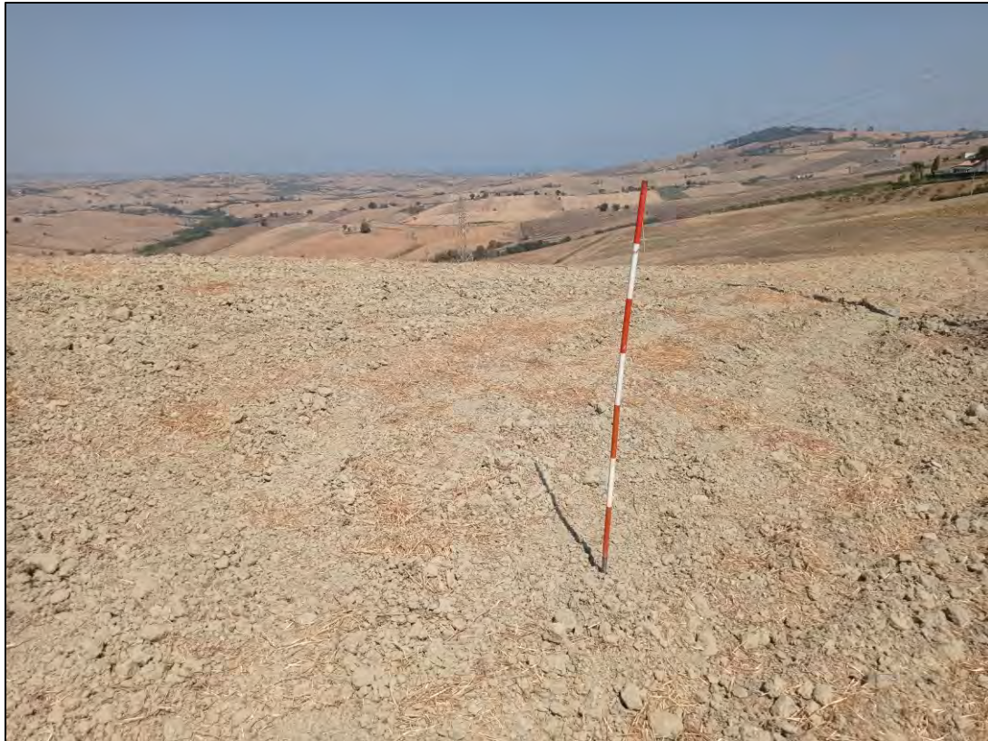
Fig. 31: cavidotto – terreno lungo la SP 124
