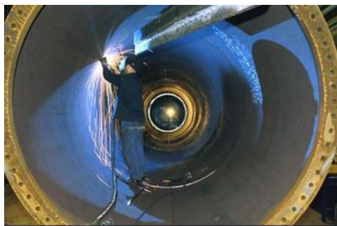
Figura 17: interno di una torre
