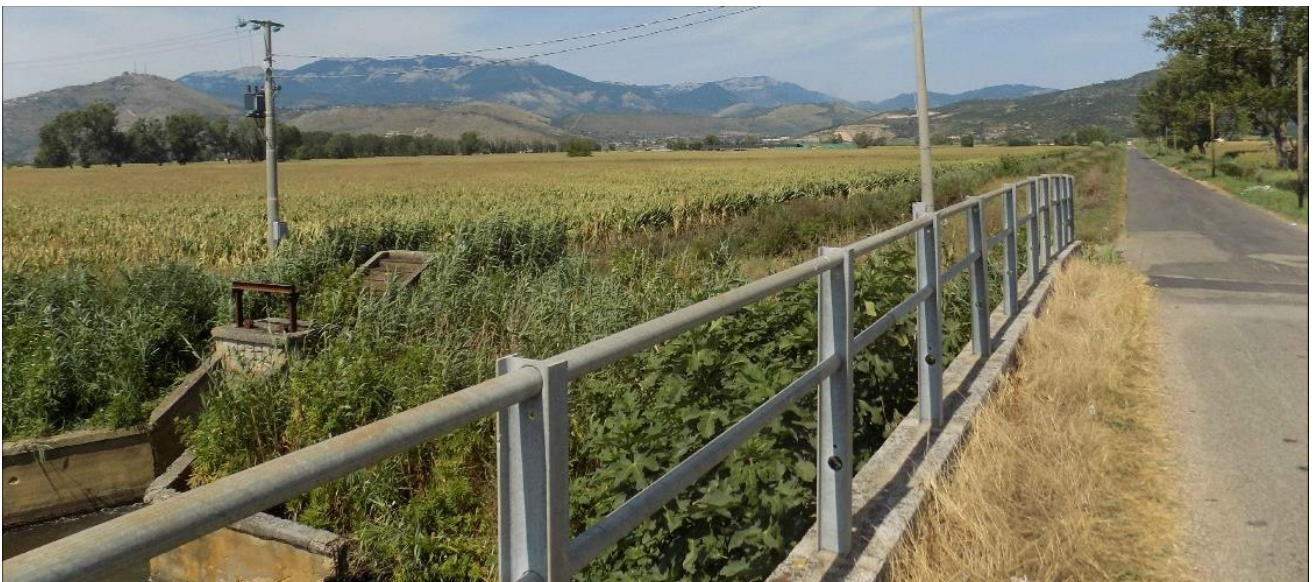
2_ "via Migliara 48 sx"_ Foto dello stato di fatto
