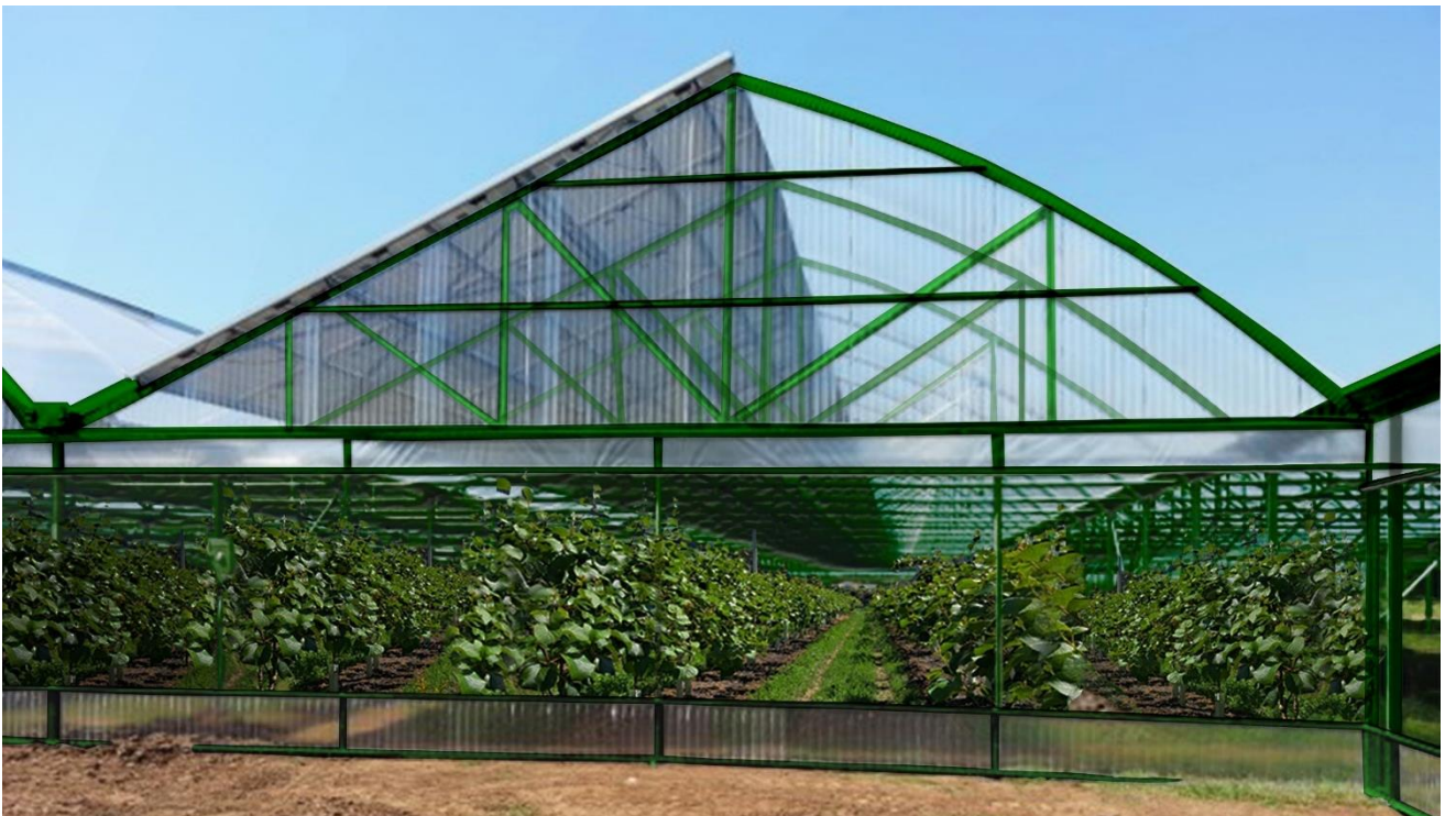
Figura 8 – Vista frontale della struttura serricola agrovoltica (filari di "Actinidia Chinensis" sotto terra)
