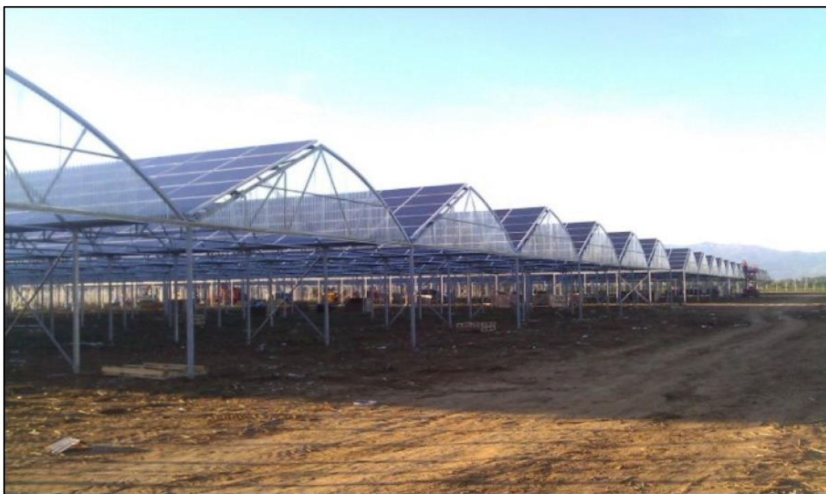
Figura 32 Schema configurazione progetto agri voltaico con pannelli montati su serre
