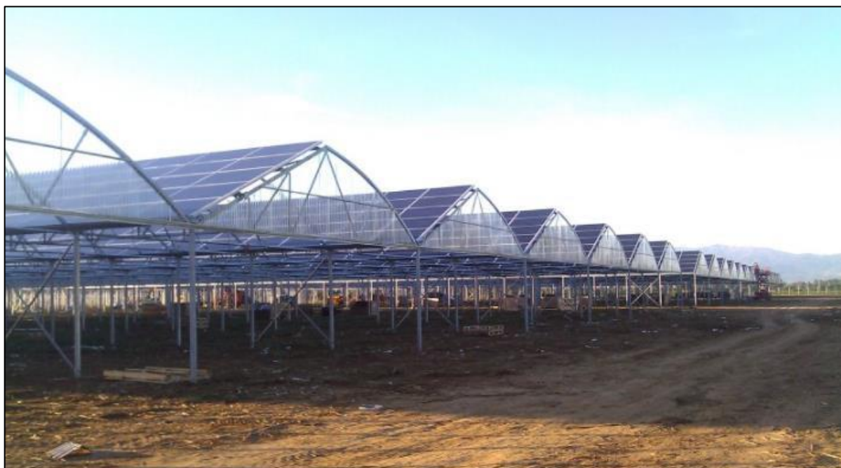
Figura 22 impianto posizionato su serra
