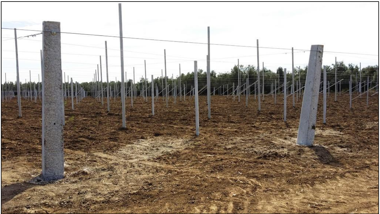
Figura 29. Piloni di ancoraggio cavi
