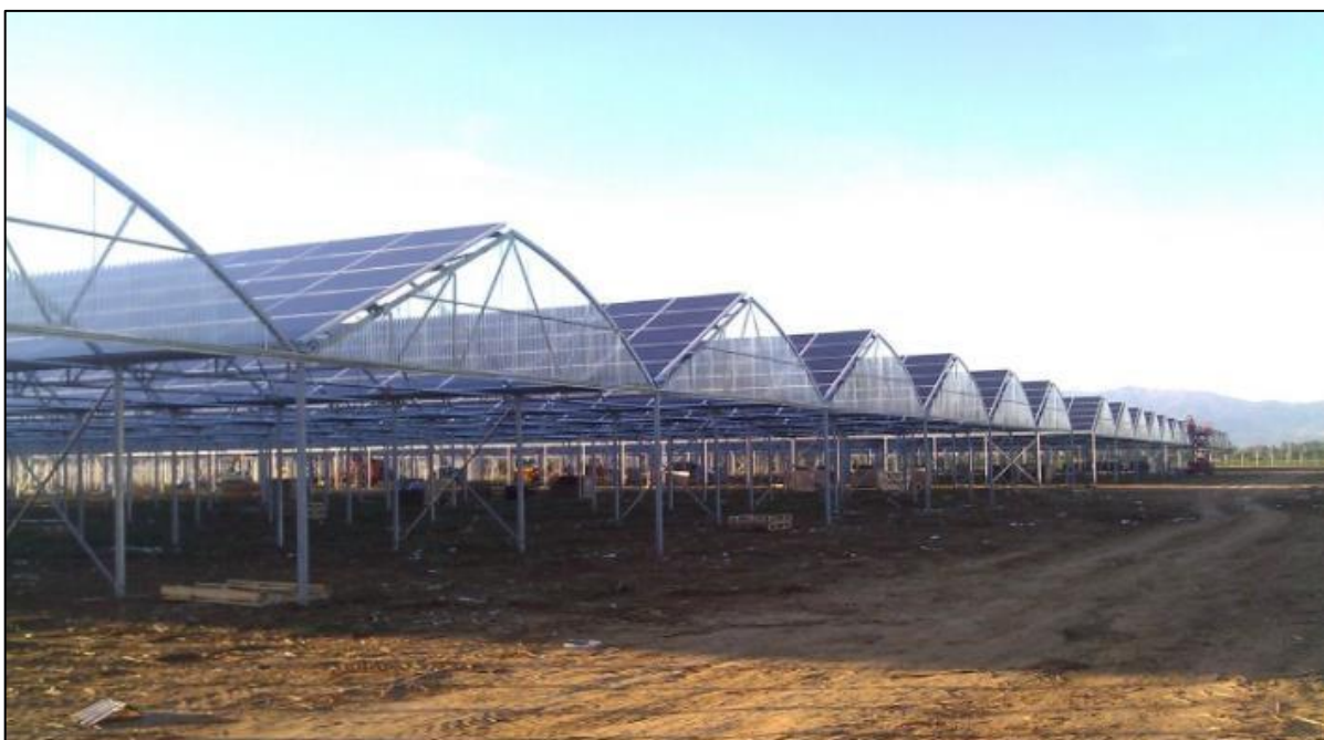
Figura 5 impianto posizionato su serra
