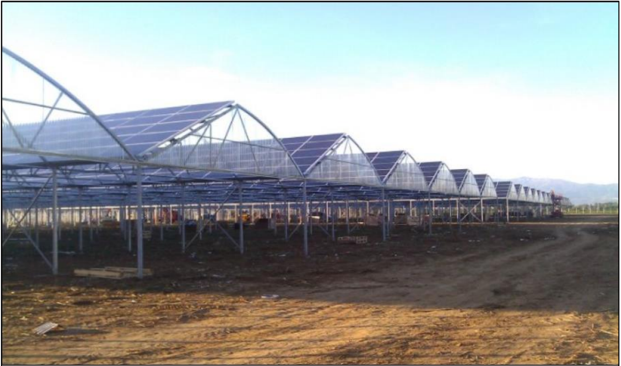
Figura 19 Schema configurazione progetto agri voltaico con pannelli montati su serre
