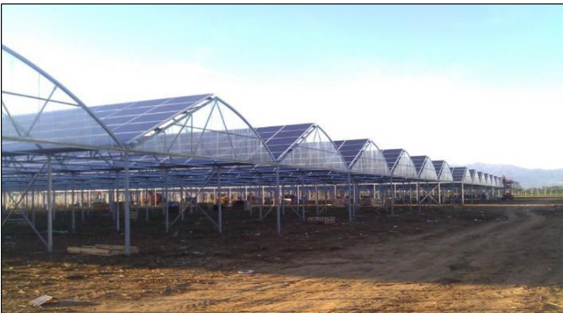
Figura 15 Impianto posizionato su serra
