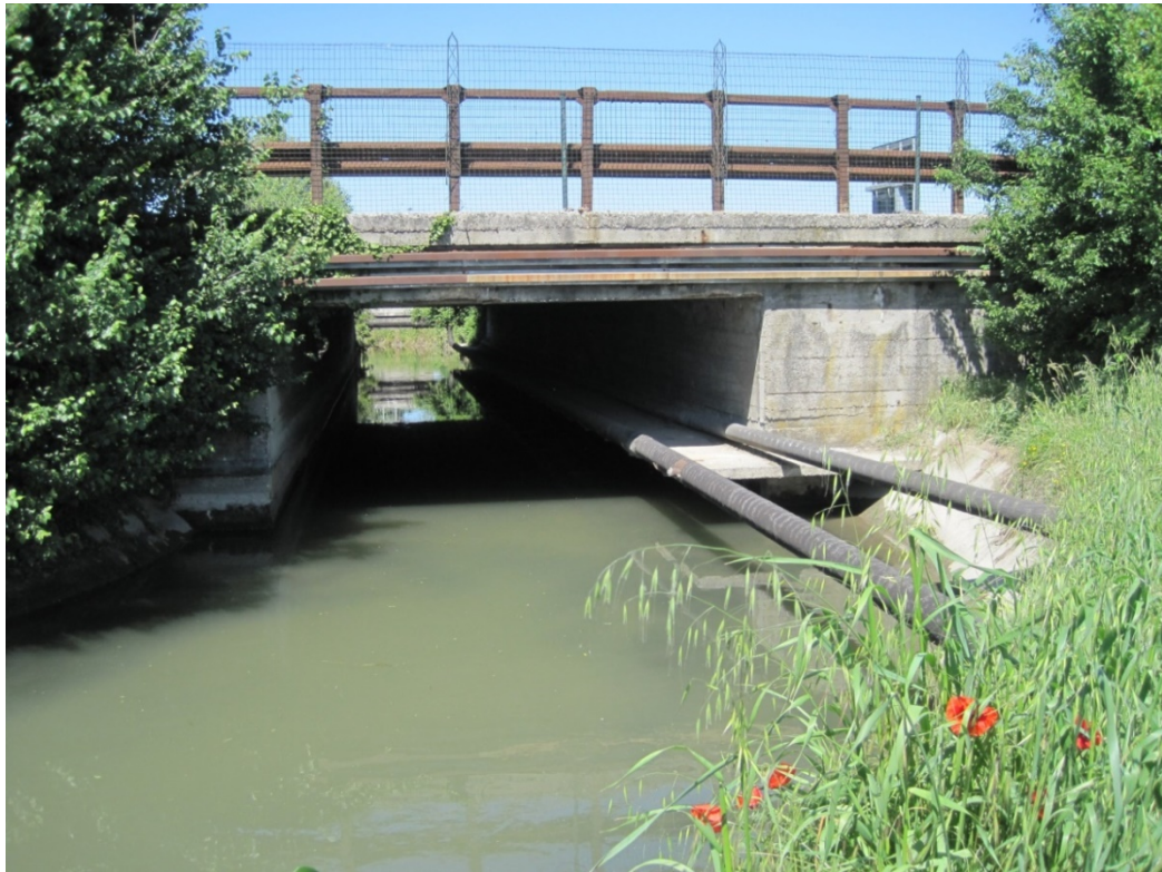
Foto 2. Opera di attraversamento del Fiume Tione
