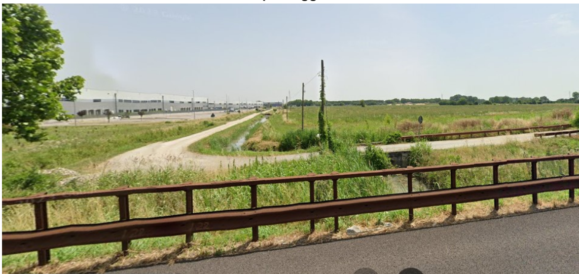
La Fossa Draga in corrispondenza dell'attraversamento dell'A22 presso Corte Carbonara e la zona produttiva "District Park": un canale privo di particolare valenza paesaggistica e ambientale
