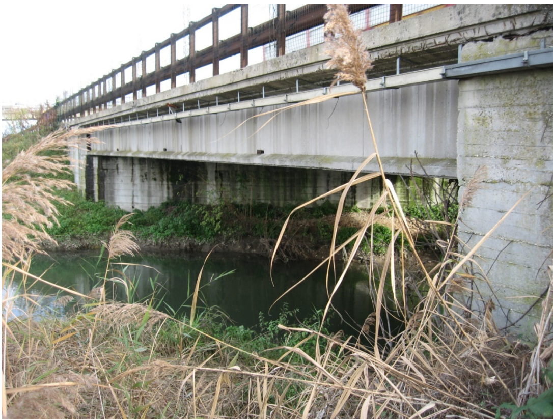
Foto 1. Opera di attraversamento del Fiume Tartaro
