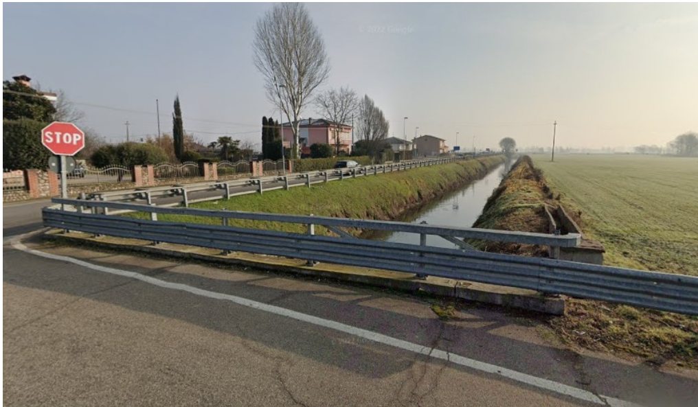
Il fiume Tartaro a Povegliano in corrispondenza del ponte della SP 52: un canale di minore valenza paesaggistica e ambientale
