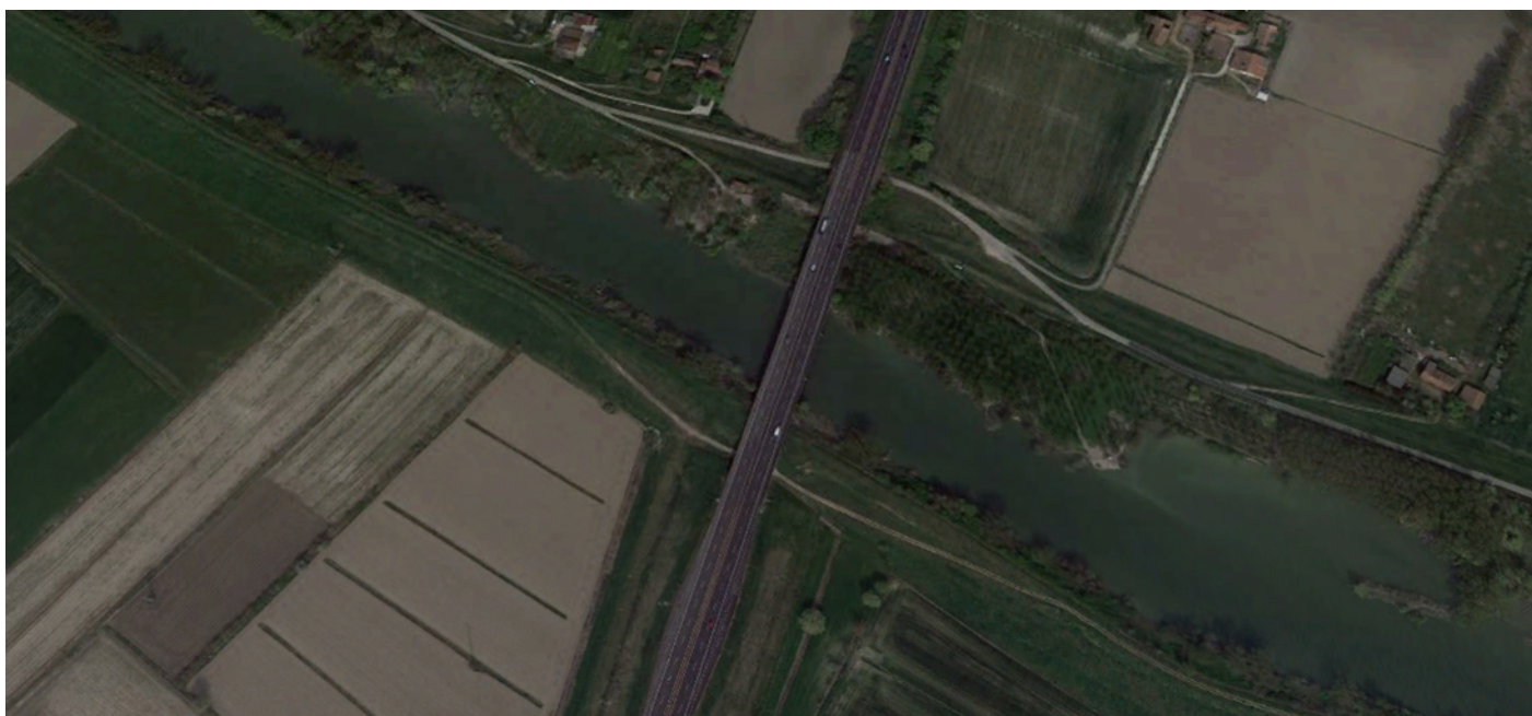
FIG. 8 - IMMAGINE AEREA DEL PONTE DELL'A22 SUL FIUME MINCIO (DA GOOGLE EARTH)
