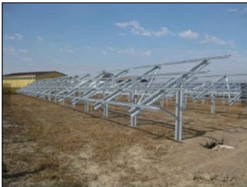
DETTAGLIO SOTTOCAMPO FOTOVOLTAICO 30 kWp
