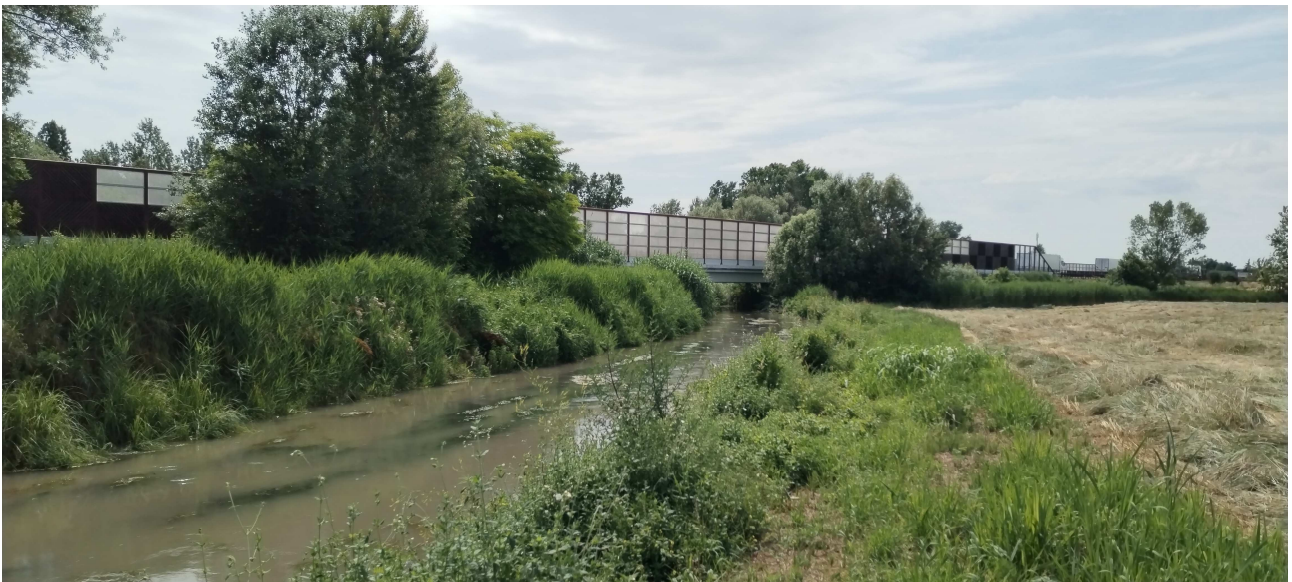
Figura 4-4. Vista da monte della dell'attraversamento autostradale esistente.
