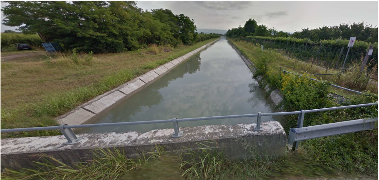
Figura 3-3. Vista del Diramatore Sommacampagna presso via Corte Salvia (VR), a monte dell'attraversamento da parte dell'A22.
