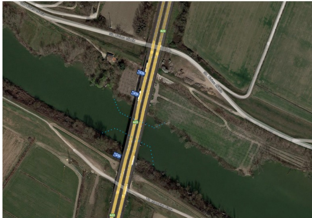
Fig. 9/5.3.1 Particolare dell'area d'intervento sponda sinistra
