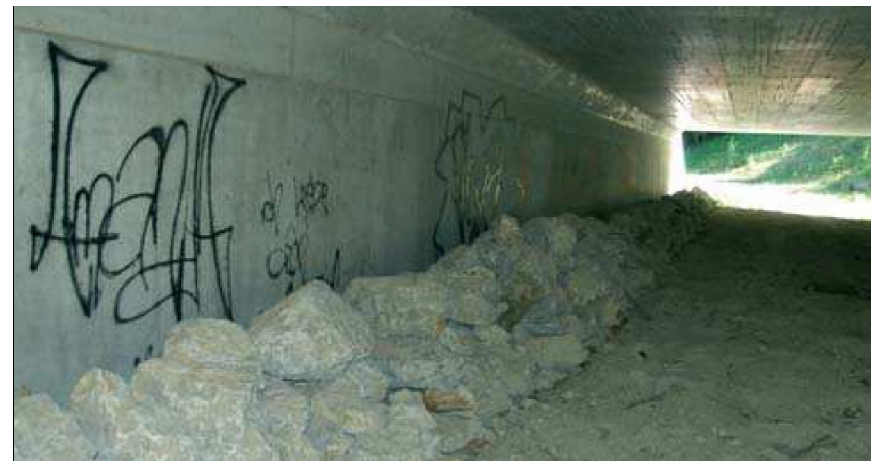
Fig 5/7.5.1 Esempio di adeguamento faunistico di manufatto idraulico mediante posa di massi
