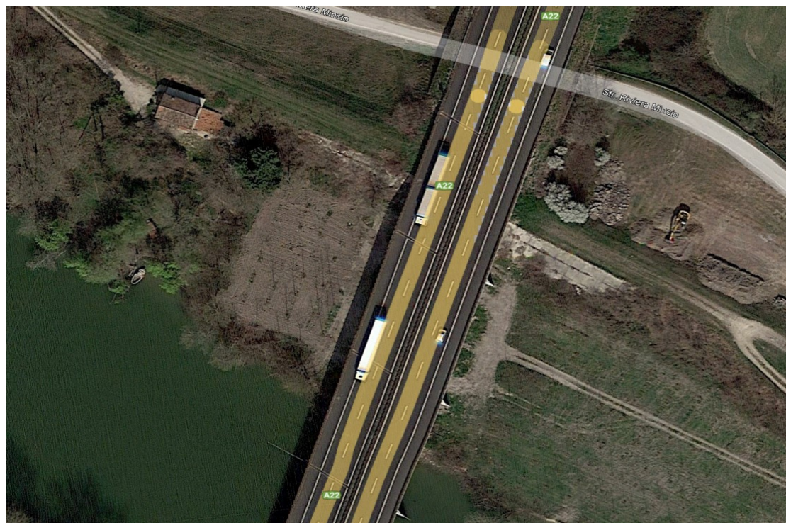
Fig. 10/5.3.1 Particolare dell'area d'intervento sponda destra
