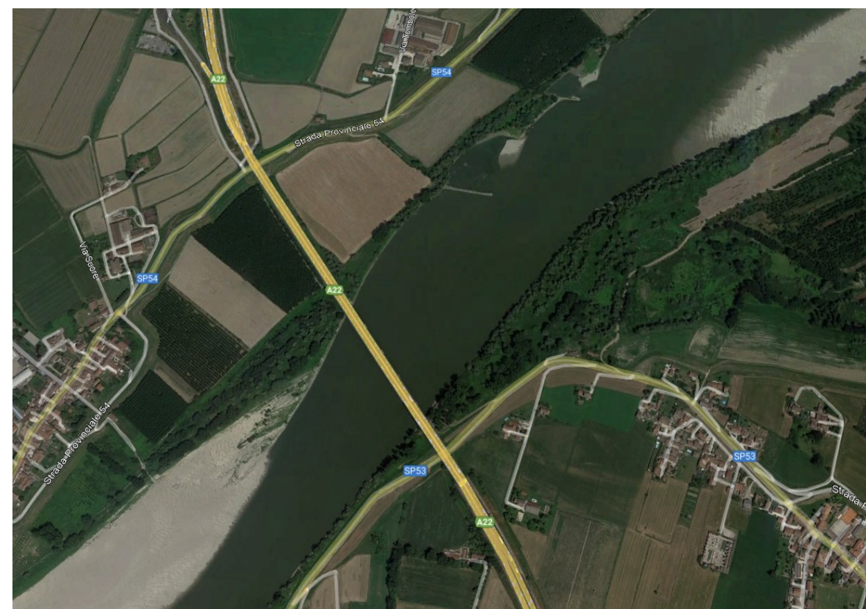
Fig. 2 /6.3.1 – Foto aerea dell'attraversamento fluviale oggetto dell'intervento
