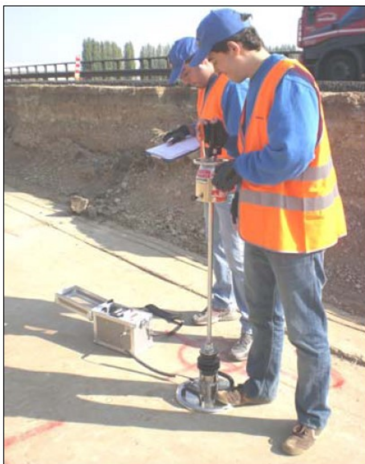
Fig. 2/4.2.4 – Indagini condotte sulle caratteristiche meccaniche dei terreni presenti nell'attuale spartitraffico
