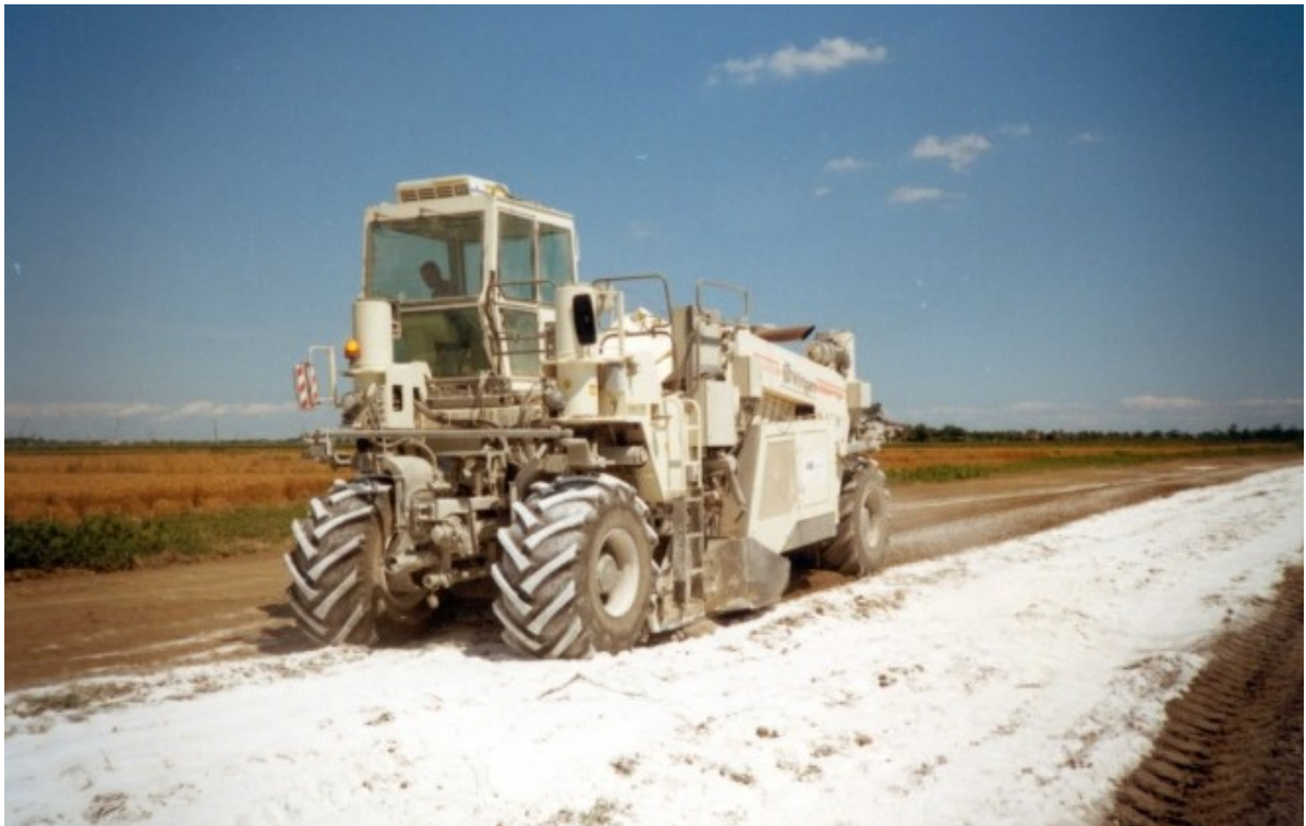
Fig. 4/4.2.4 - Mezzi per lo spandimento e il mescolamento della calce
