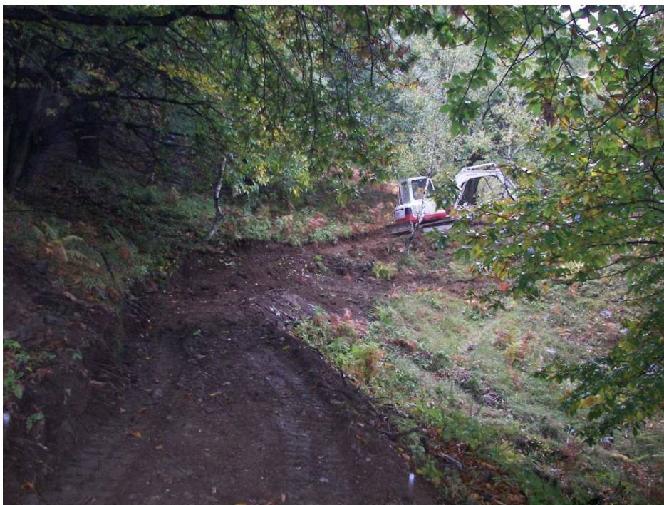
Figura 8: Foto raffigurante un esempio di pista di cantiere Tipo II.
