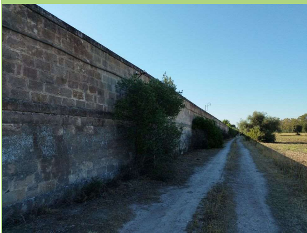
Foto 29. Muro perimetrale della ex-polveriera.
