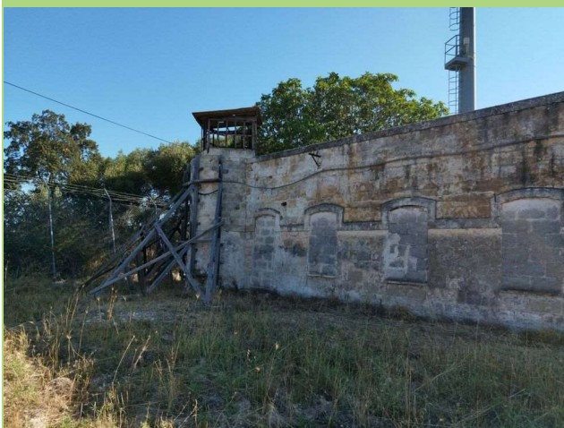
Foto 27. Torretta di avvistamento e muro perimetrale della ex-polveriera.
