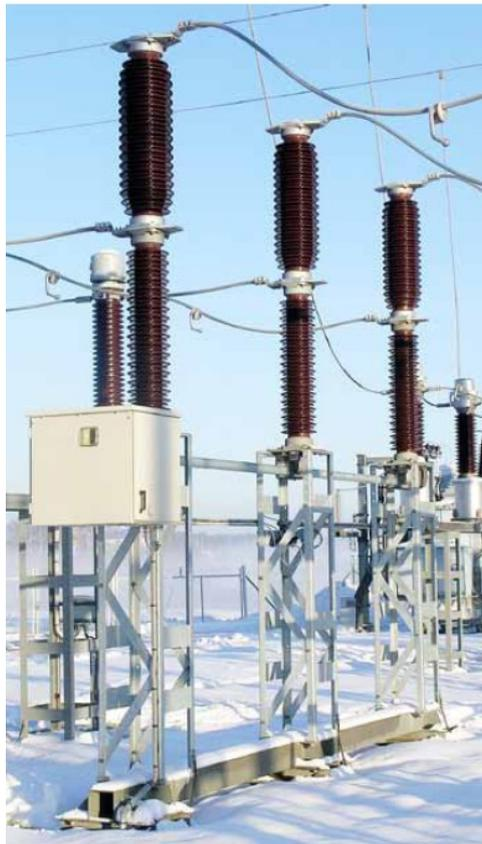
**Fig. 22. Particolare Interruttore con TA incorporato.**
