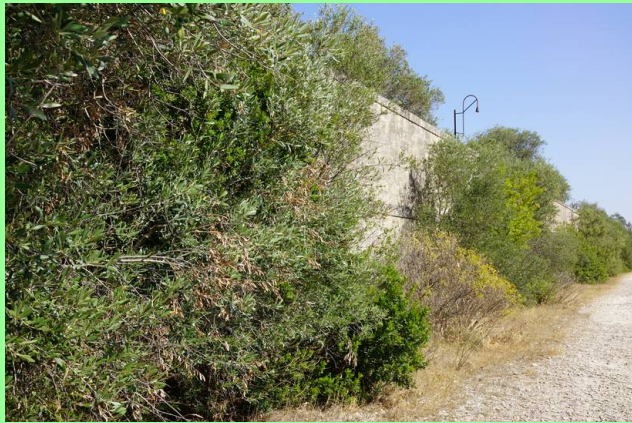
Figura 17: Comunità dei substrati artificiali a contatto con la Macchia arbustiva (Muro perimetrale della polveriera; Punto rilievo: W139).
