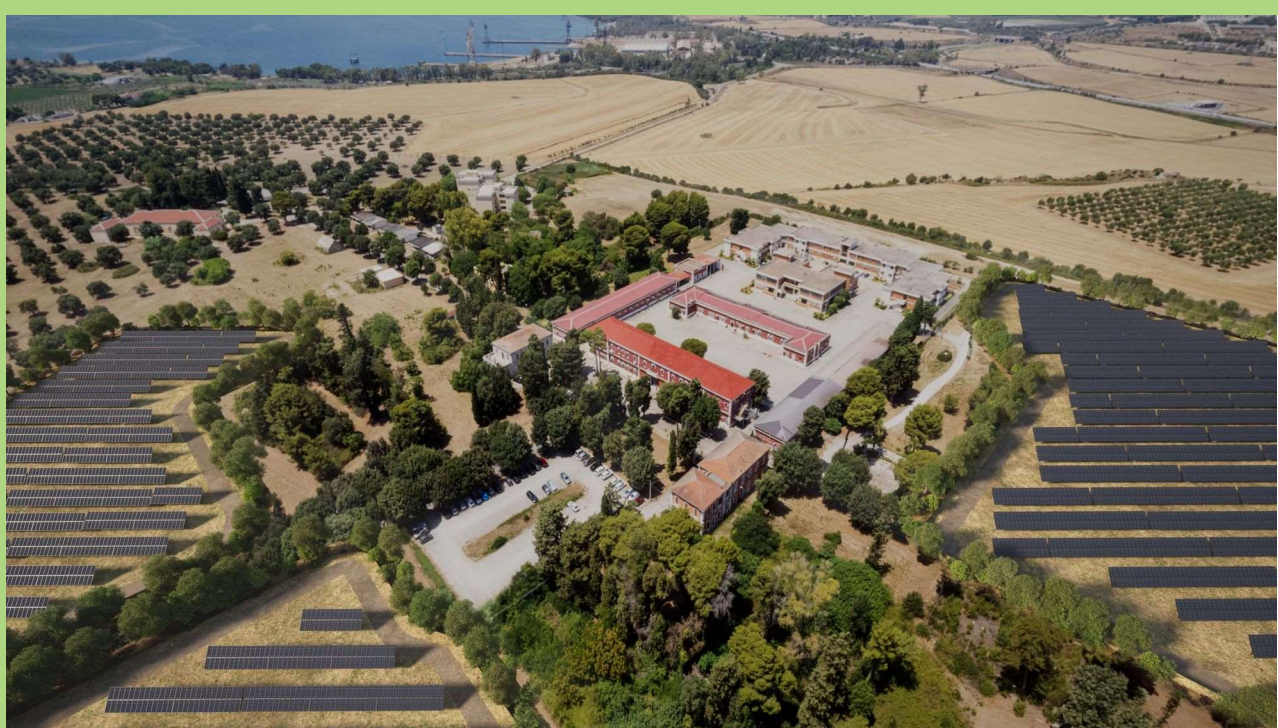
Figura 2. Rappresentazione dello stato di progetto. Gli edifici del comando DIREMUNI circondati dal Pascolo Solare.
