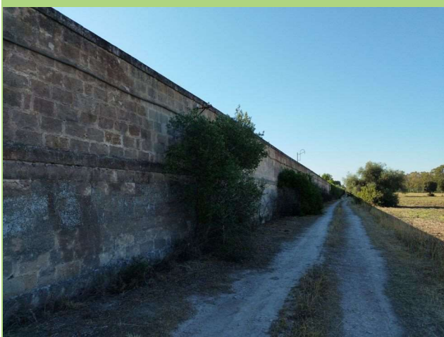
Foto 29. Muro perimetrale della ex-polveriera.
