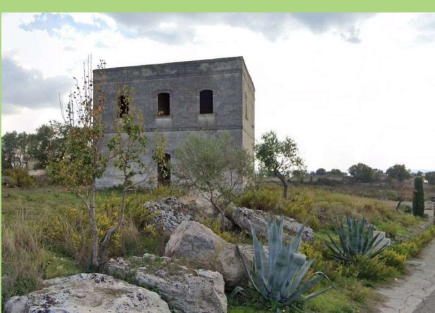
Foto 19. Casello ferroviario della linea chiusa Nasisi - Taranto Arsenale, oggetto delle misure di compensazione.
