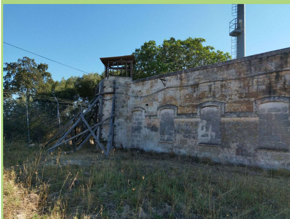
Foto 28. Torretta di avvistamento e muro perimetrale della ex-polveriera.
