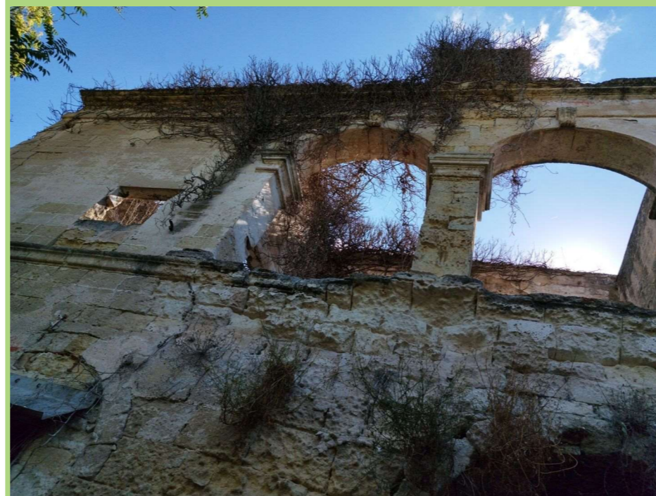
Foto 23. Particolare del fronte di Masseria Buffoluto nell'area di DIREMUNI Taranto.
