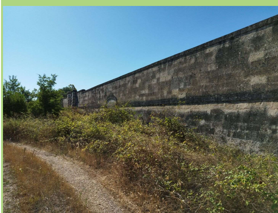
Foto 37. Muro perimetrale della ex-polveriera.
