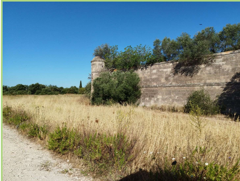
Foto 31. Torretta di avvistamento e muro perimetrale della ex-polveriera.
