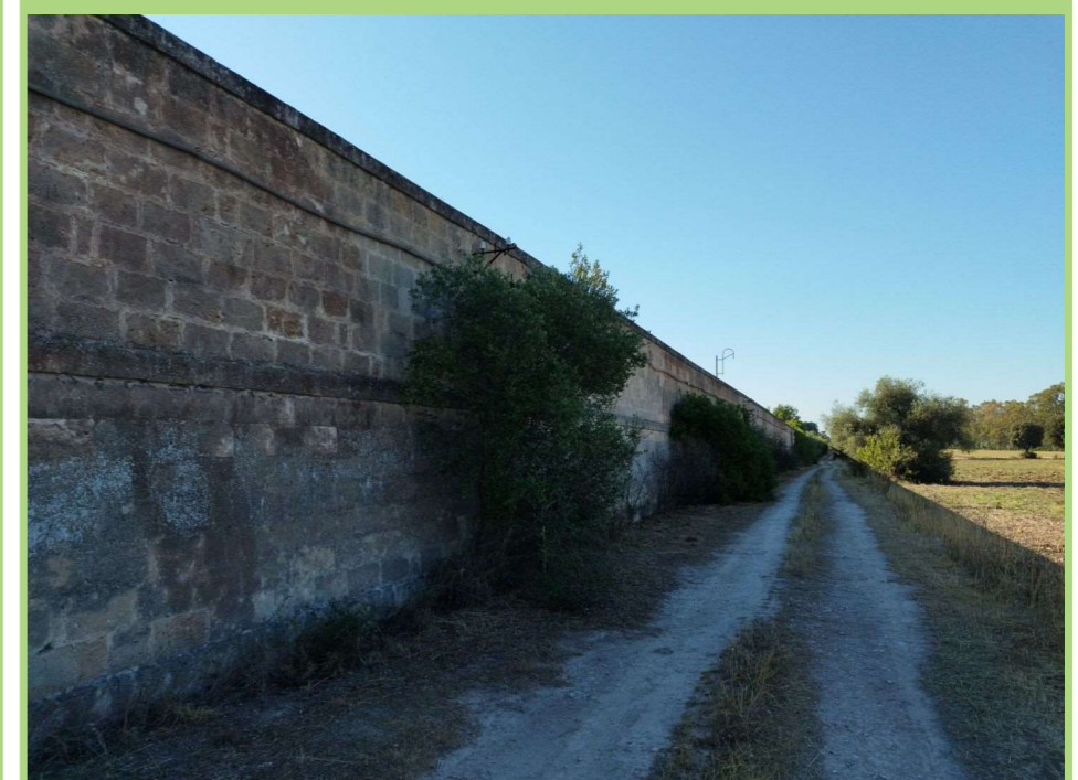
Foto 30. Muro perimetrale della ex-polveriera.
