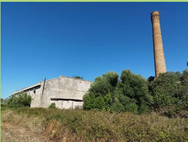
Foto 43. Fabbricati diruti nell'area DIREMUNI Taranto. Ciminiera per la produzione di materiale pirico.
