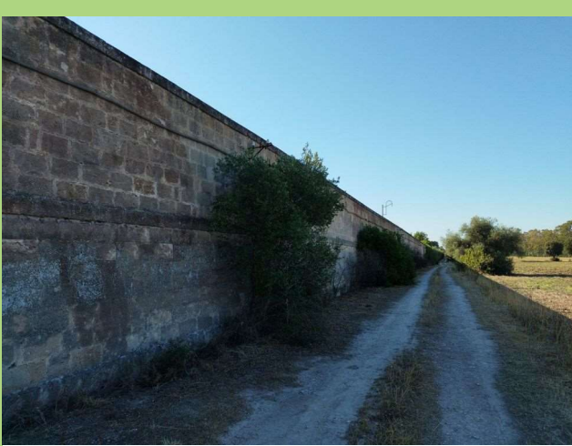
Foto 29. Muro perimetrale della ex-polveriera.
