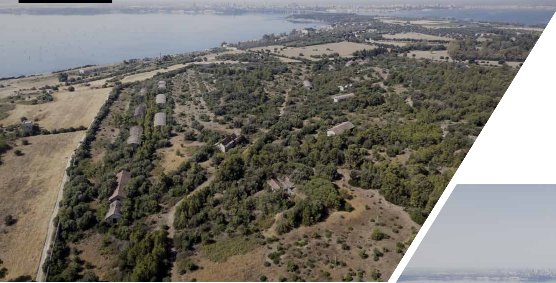
lo stato attuale dei luoghi
