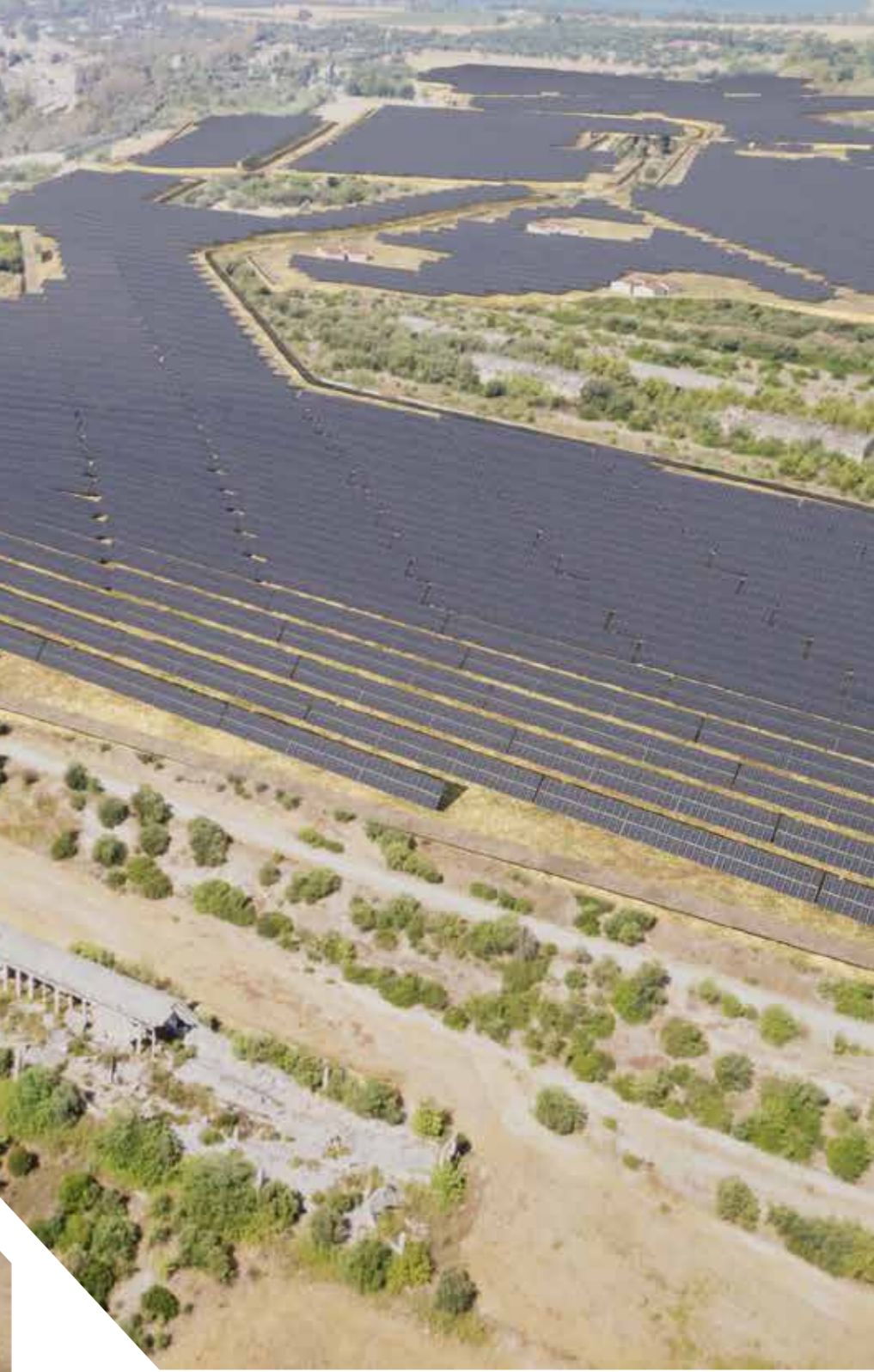
lo stato attuale dei luoghi
