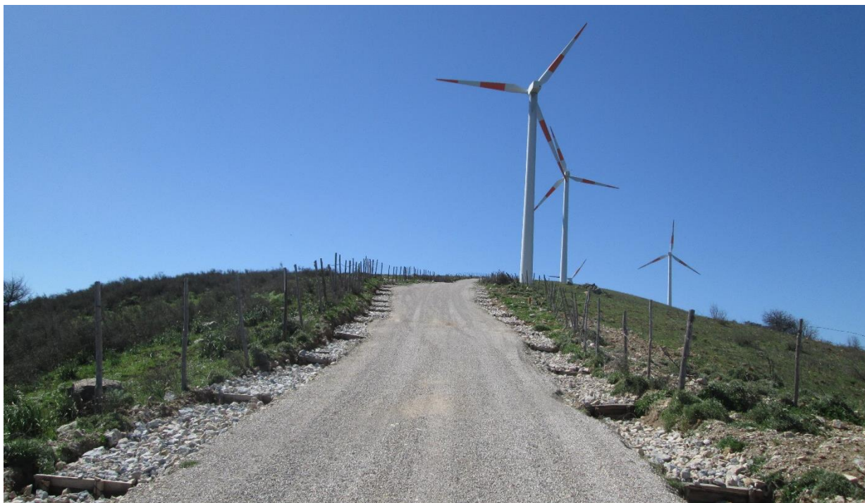
Figura 5.2- Sistema di fossi di guardia con fondo rivestito in pietrame e briglie.
