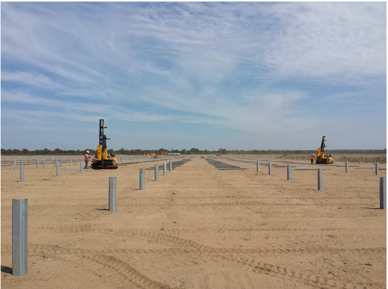
Figura 2.6 – Fase di infissione dei pali con profilo omega (fonte Convert)
