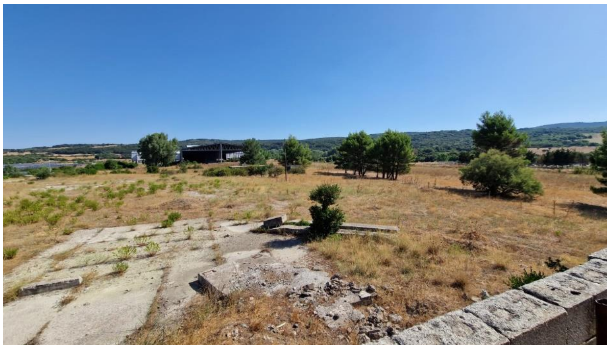
Figura 3-14 - Area abbandonata e particolarmente degradata
