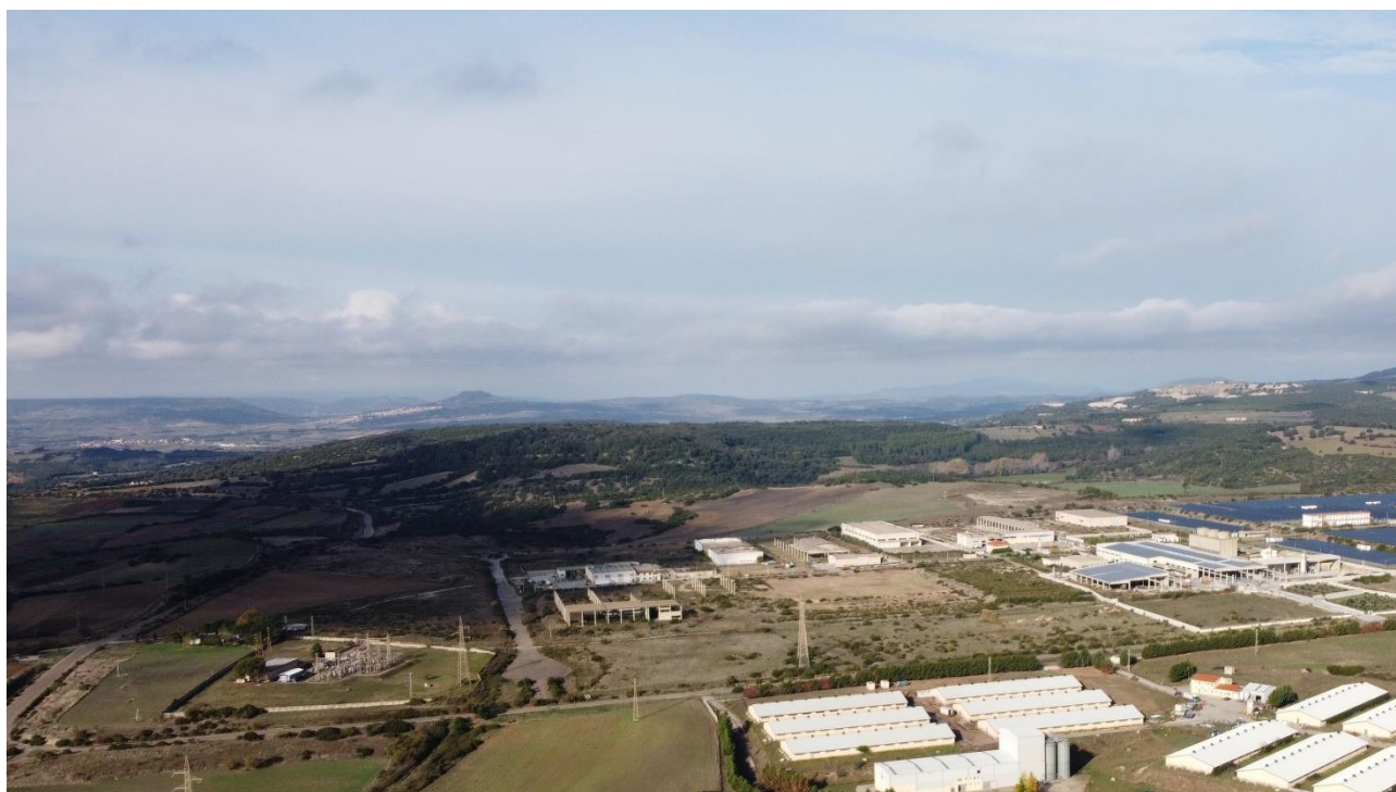
Figura 10.6 – Vista sull’area della Cabina Primaria CP, localizzata nella porzione sud-est dell’agglomerato industriale e visibile a sinistra nella foto. Ripresa aerea da est verso ovest (P.to 5)
