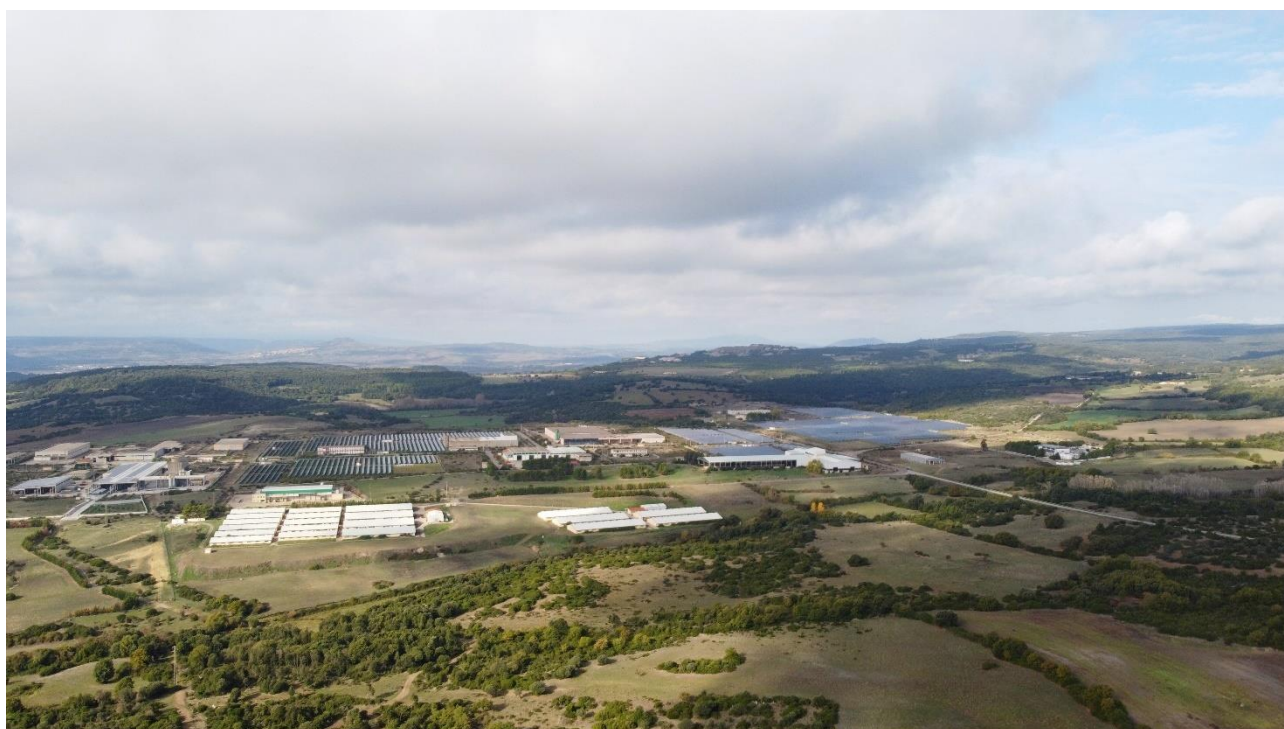
Figura 8.9 - Vista sulla porzione orientale dell'impianto. Ripresa aerea da est verso nord-ovest
