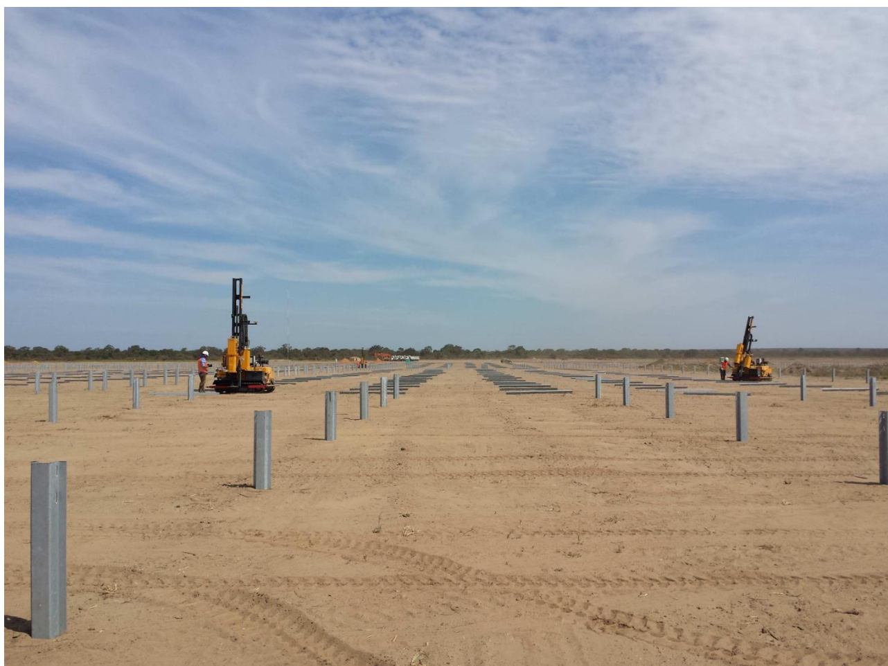
Figura 5.3 – Fase di infissione dei pali con profilo omega (fonte Convert)
