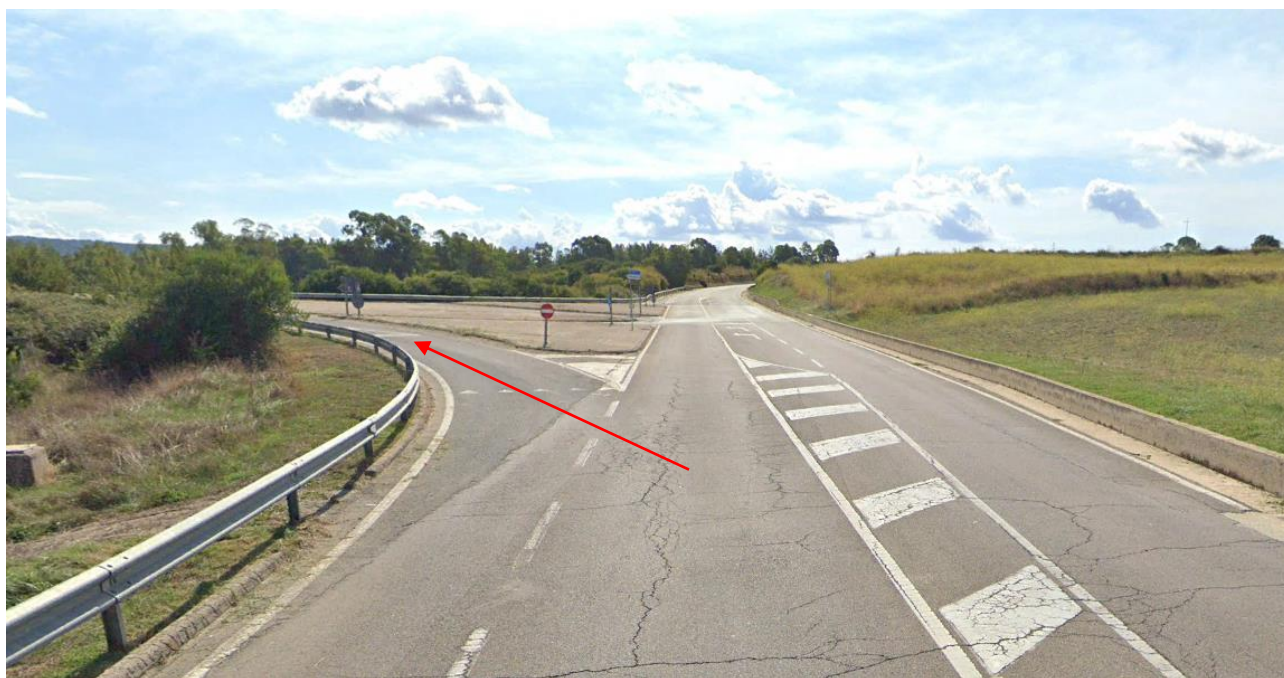
Figura 10.8 – Punto di innesto tra la SS 128 Centrale Sarda e la viabilità secondaria - che dopo la Zona Industriale prenderà il nome di Strada Comunale Ruina Ponti - che garantisce l'accesso alla Zona Industriale e all'area di impianto. Foto estrapolata da Google Earth con vista da nord-ovest verso sud-est (P.to 7)
