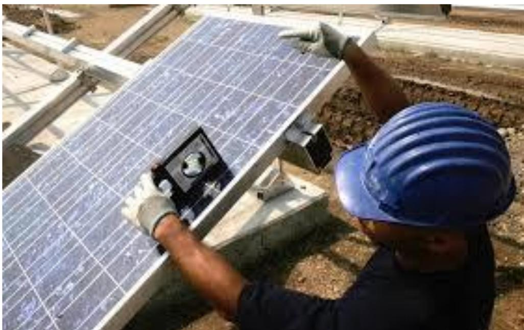
**Figura 8. Operai montatori di pannelli fotovoltaici su suolo**
