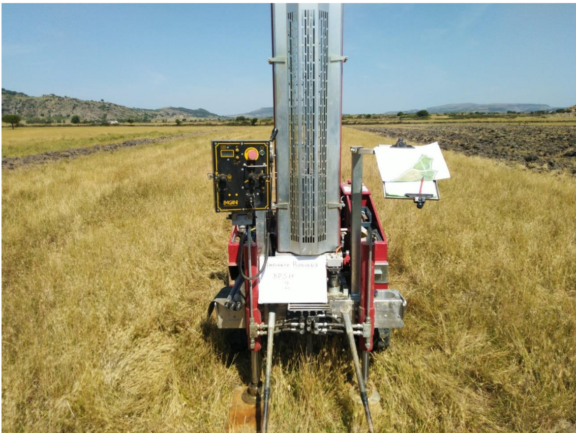
Figure 2: Postazione prova penetrometrica DPSH 2
