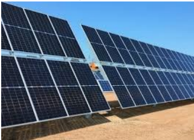
Figura 3: Tracker bifilare
