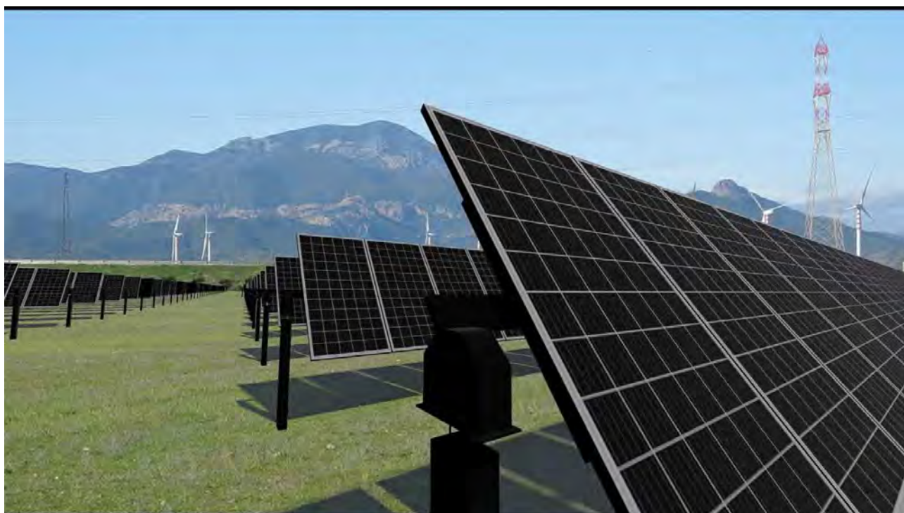
Foto 4 – Post operam – Punto 4
