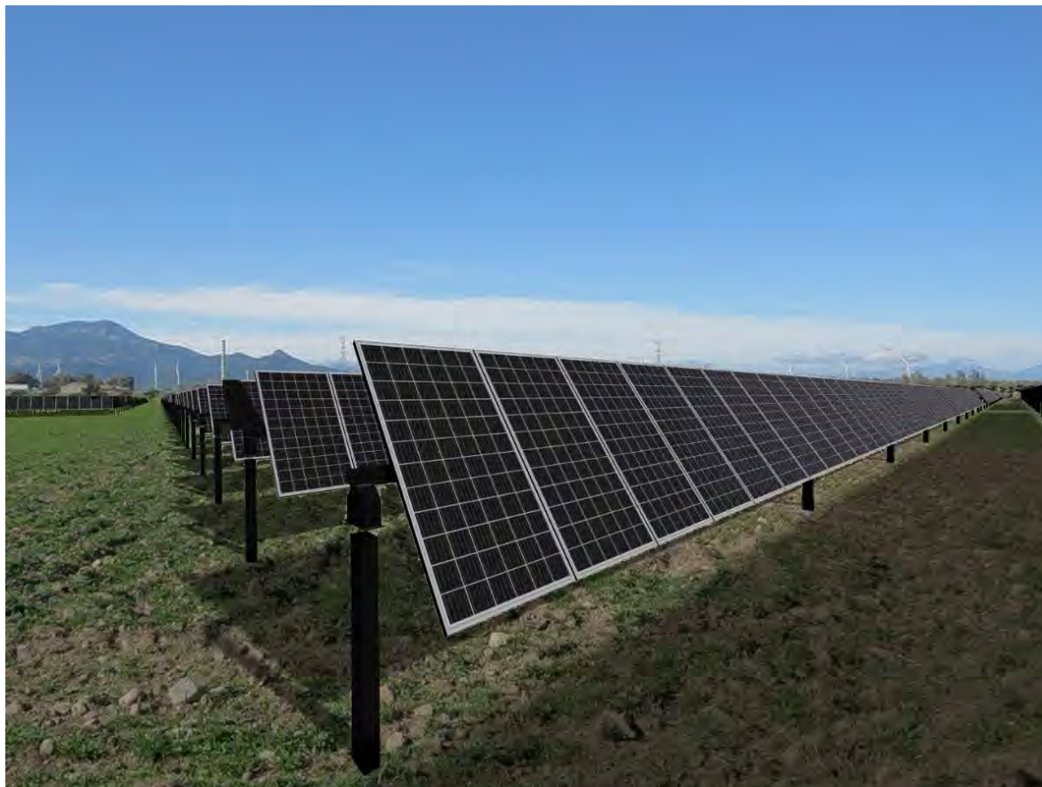
Foto 5 – Post operam – Punto 5
