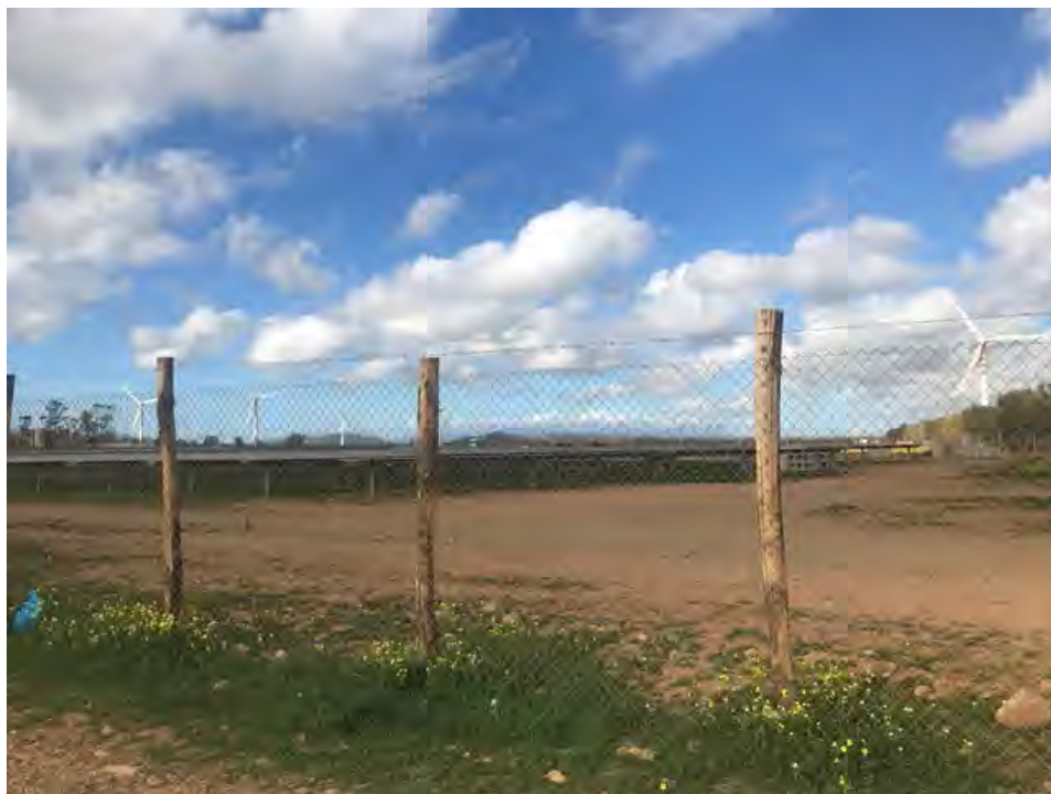
Immagine 13: Tipologia recinzione
