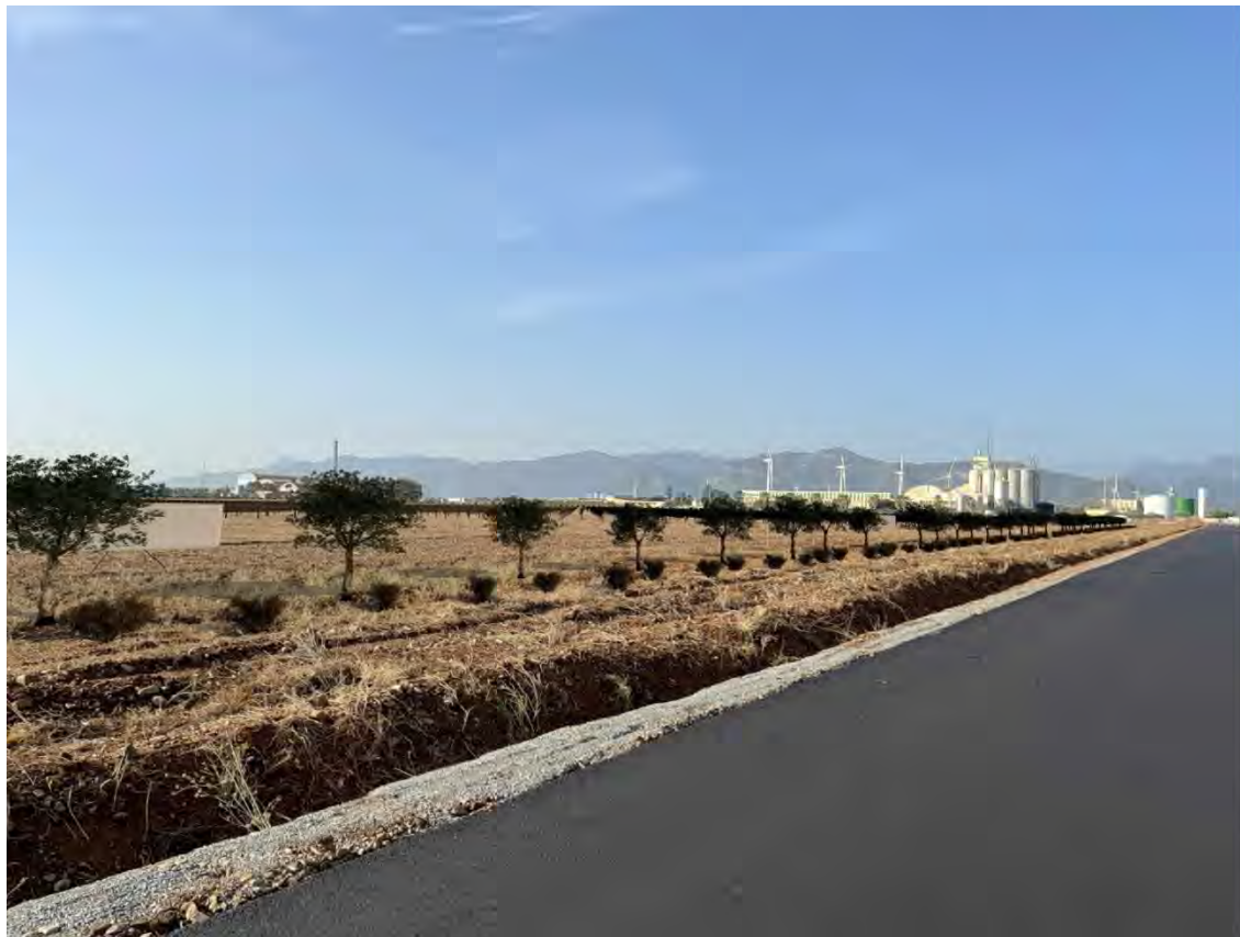
Foto 1 – Post operam – Punto 1
