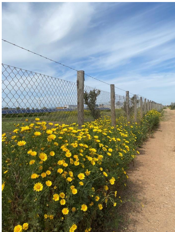
Immagine 3.4: Tipologia recinzione
