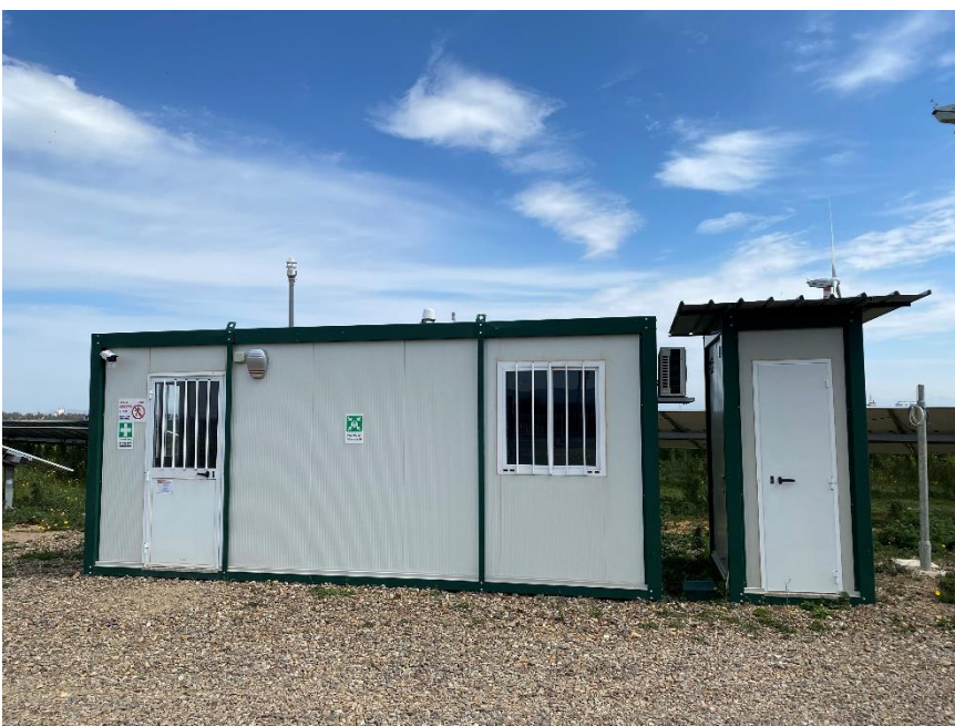
Immagine 3.4: control room e wc chimico
