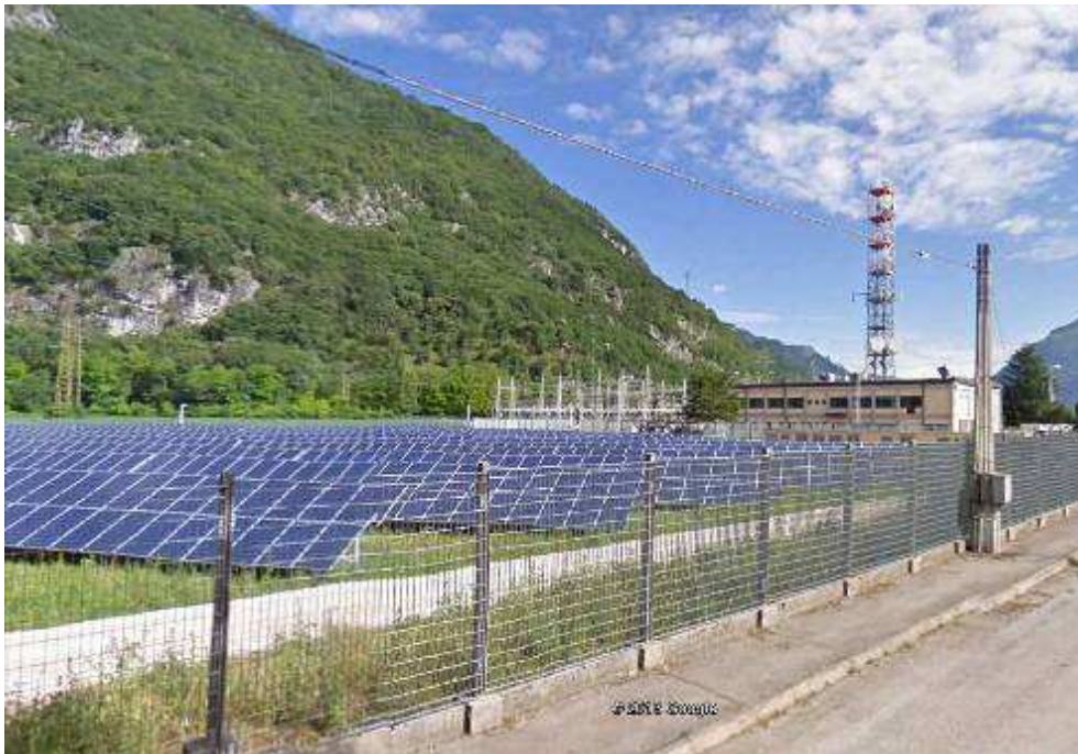
stazione elettrica esistente
