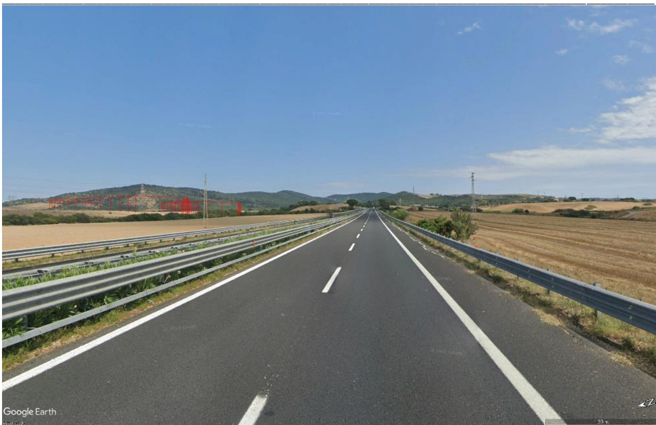
Figura 7 – vista dei terreni di progetto dalla A12 (schematizzazione su Street View)
