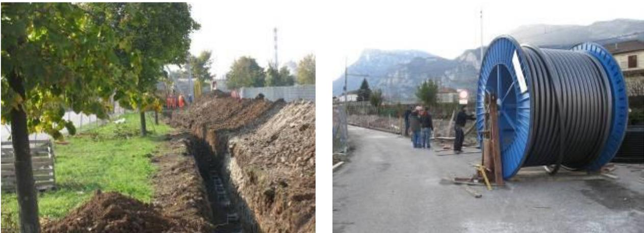
Figura 2-38. Posa rulli lungo lo scavo e stendimento del cavo.
