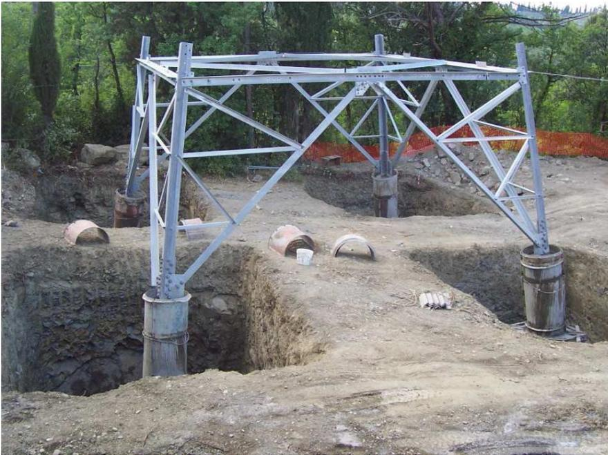
**Figura 2-12. Esempio di fondazione di un sostegno.**
