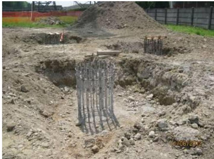
**Figura 2-14. Esempio di realizzazione di una fondazione a trivellati**
