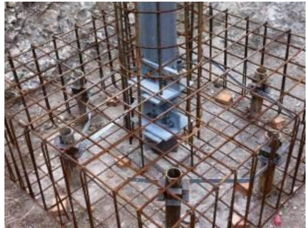
**Figura 2-15. Esempio di realizzazione di una fondazione a micropali.**
