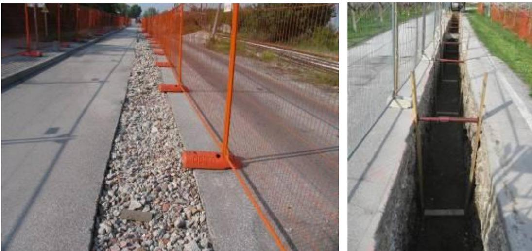
**Figura 2-36. Taglio dell'asfaltatura e scavo aperto.**
