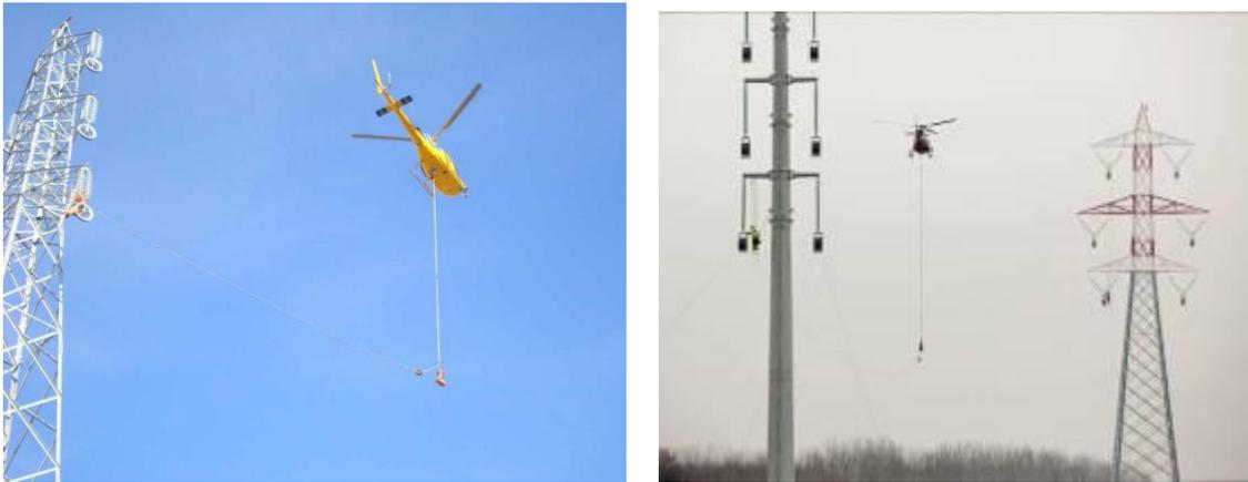
**Figura 2-17. Utilizzo dell'elicottero per la stesura della corda pilota.**
