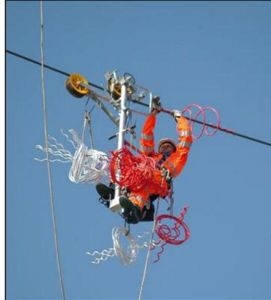
**Figura 5-6 Montaggio spirali**
