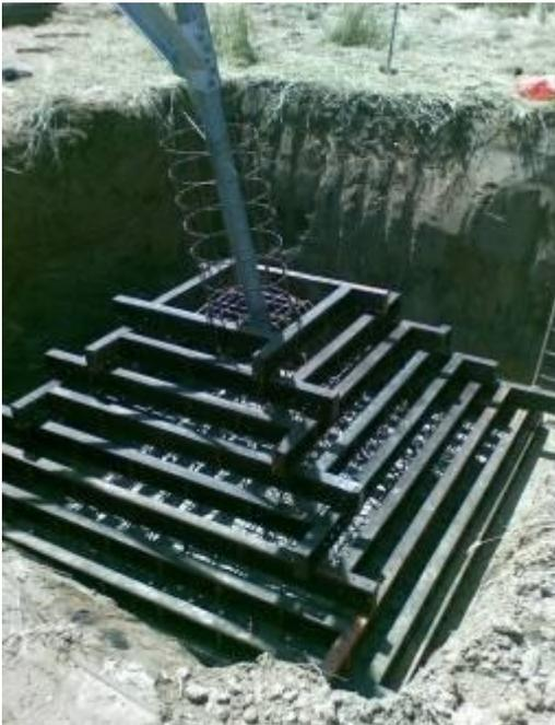
**Figura 2-13. Esempio di realizzazione di una fondazione a plinto con riseghe.**
