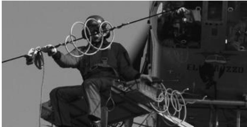
**Figura 5-2** *Installazione segnalatori ottici e ad acustici (spirali colorate in plastica).*
