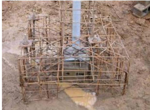
**Figura 2-16. Esempio di fondazione con tiranti in roccia.**
