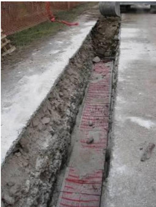
**Figura 2-41. Reinterro con posa delle piastre di protezione e rete PVC.**
