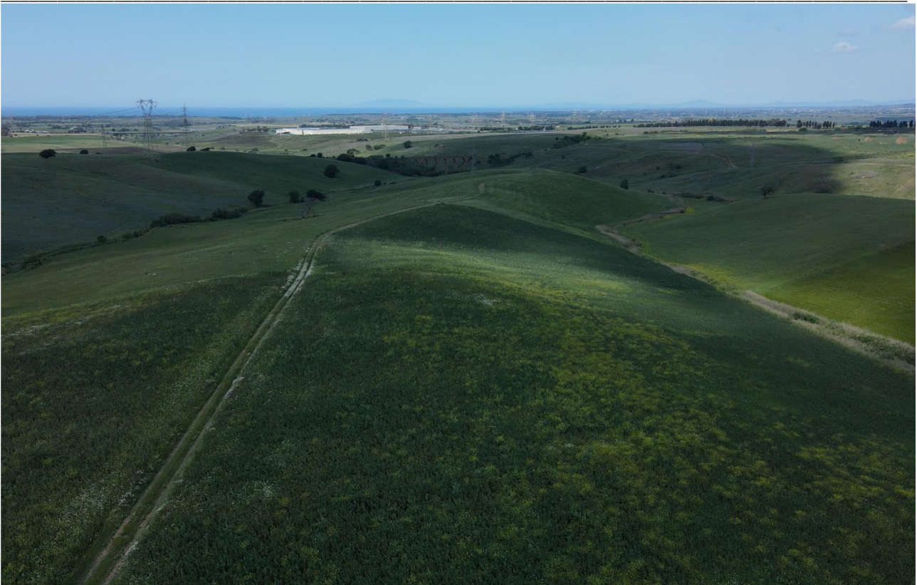
Figura 18 - foto dal drone dell'area di impianto (porzione ovest del lotto 2)
