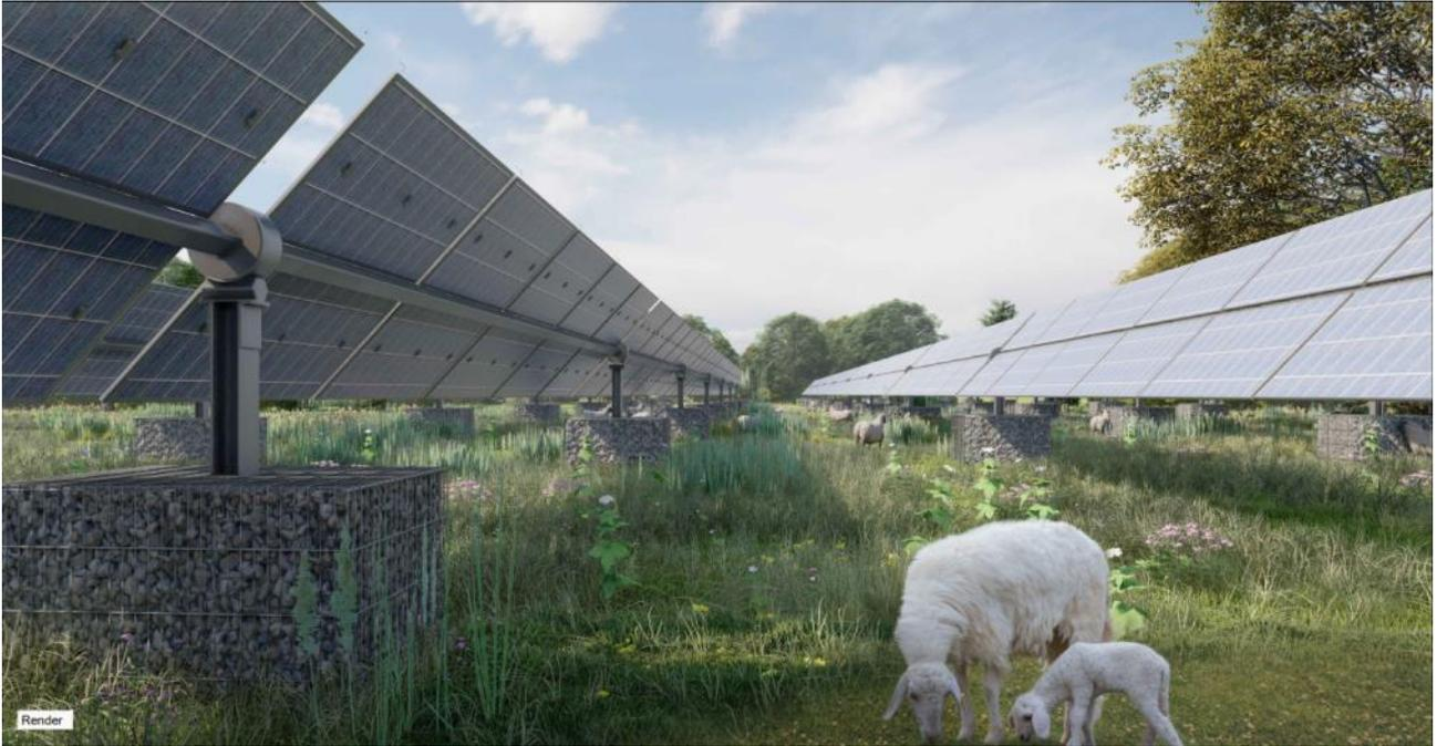
Figura 31 – strutture di sostegno dei tracker con i gabbioni riempiti di materiale lapideo
