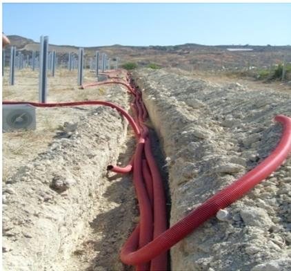
Il cavidotto avrà lo scopo di contenere i cavi che trasporteranno l'energia elettrica prodotta dalla centrale fotovoltaica al locale tecnico secondo il tracciato previsto.
