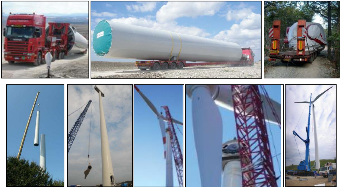
Figura 19: Trasporto e montaggio torri
