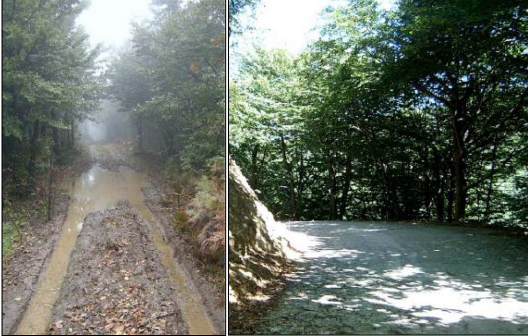
Figura 16: Strade di accesso prima e dopo i lavori di sistemazione
