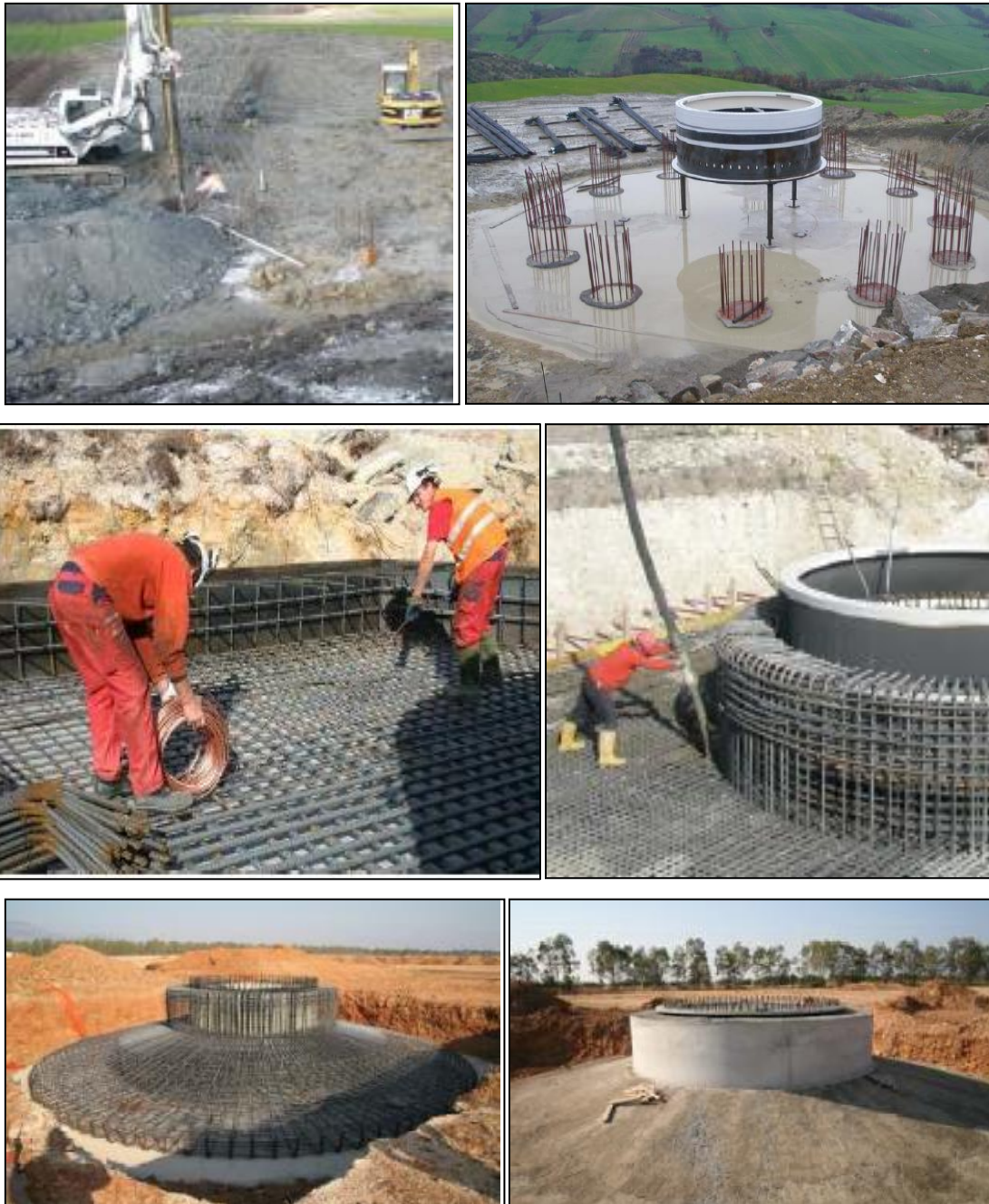
Figura 18: Fondazione aerogeneratore con pali
