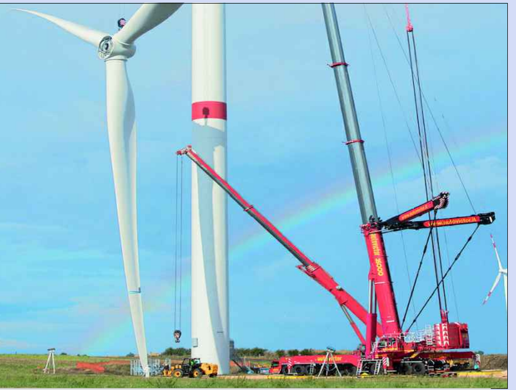
Fase di montaggio
