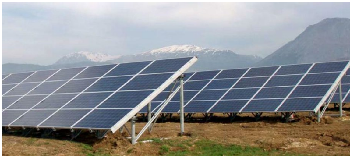
Esempio di struttura di sostegno per quattro file orizzontali di moduli fotovoltaici affiancati
