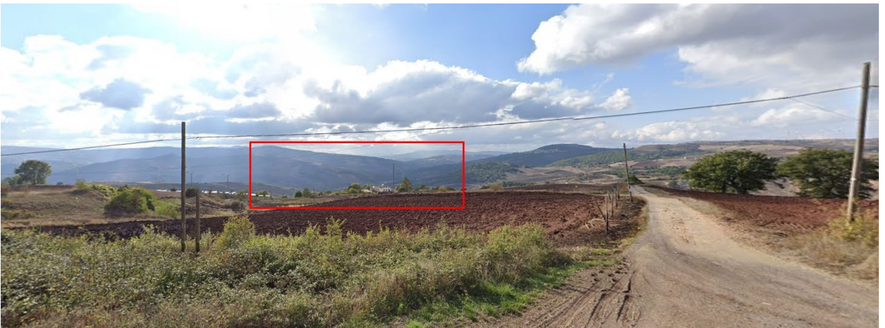
Figura 20 Posizione della WTG02 vista dalla SS7
