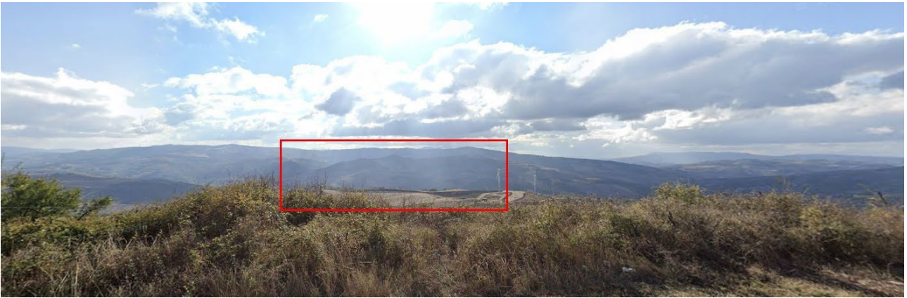
Figura 21 Posizione della WTG03 vista dalla SS7
