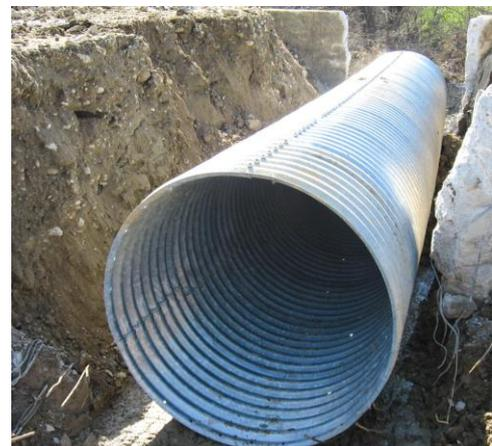
Figura 6.Esempio tubo Armco.
