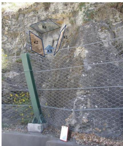
**Fig. 6.1** Spalla destra: Il cuneo di roccia mancante ben evidenzia le famiglie di discontinuità principali.
