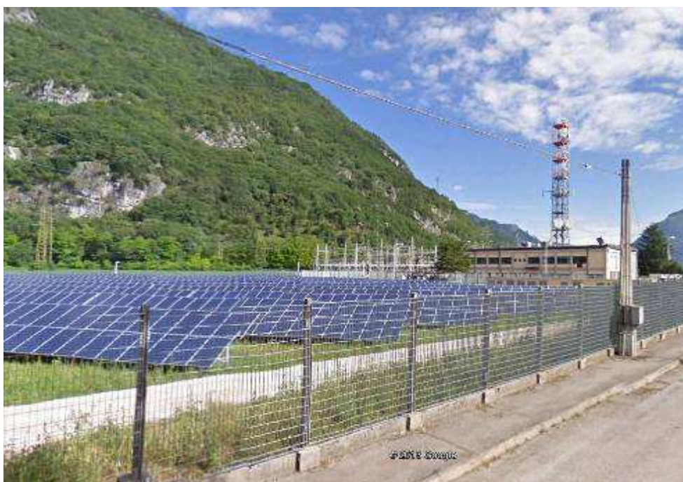
stazione elettrica esistente
