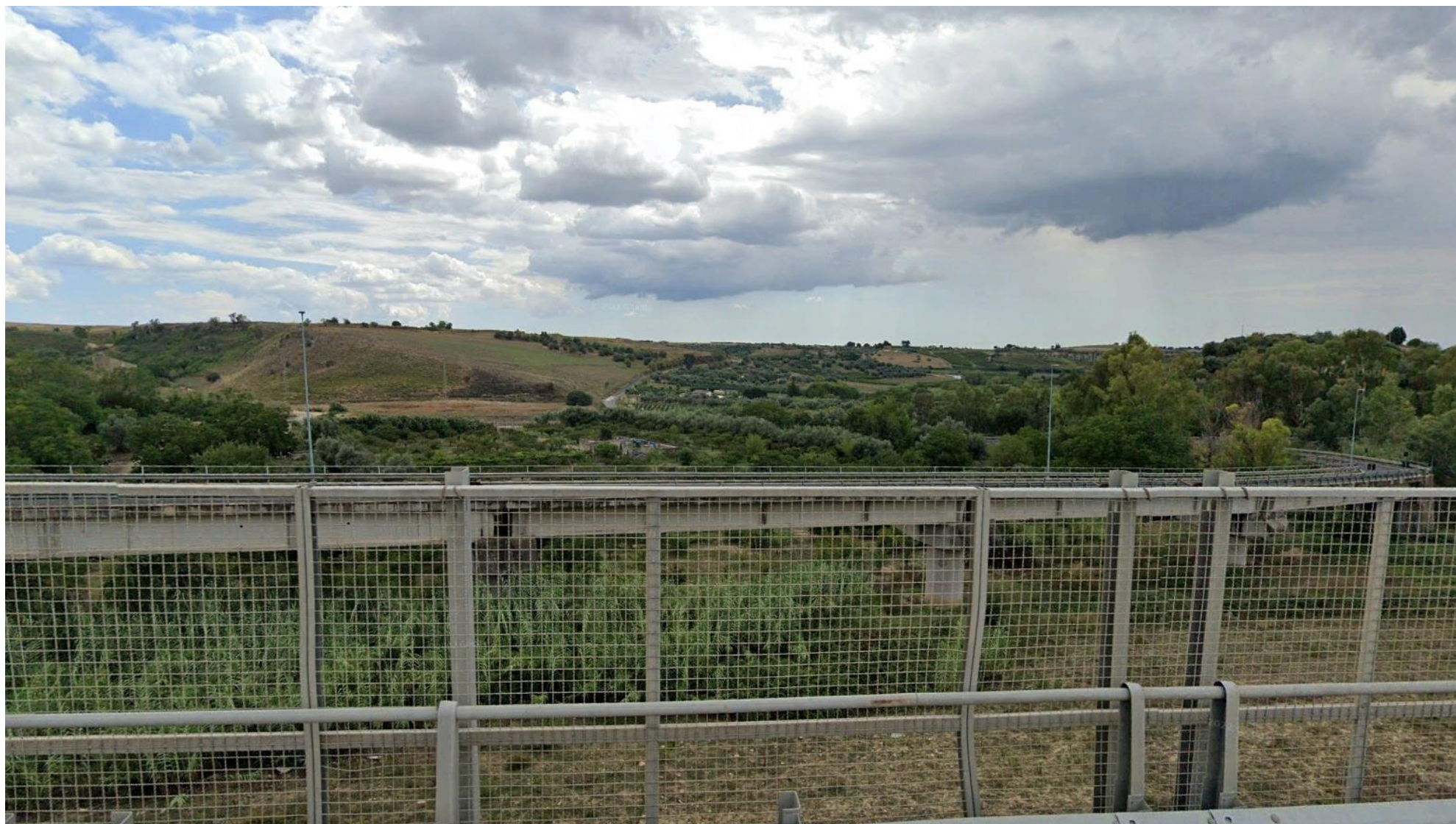
PO_01 – Caltagirone – Viadotto Favarella. Ante operam
