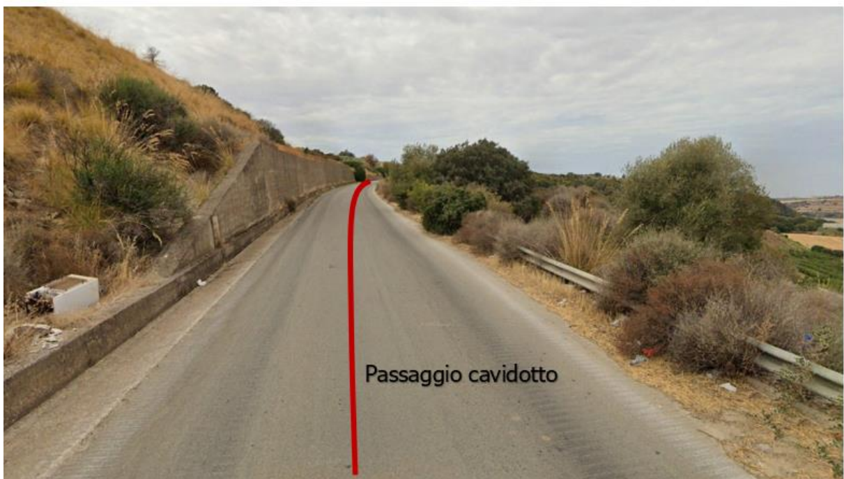
Figura 6-61 - Vista 4 passaggio cavidotto
