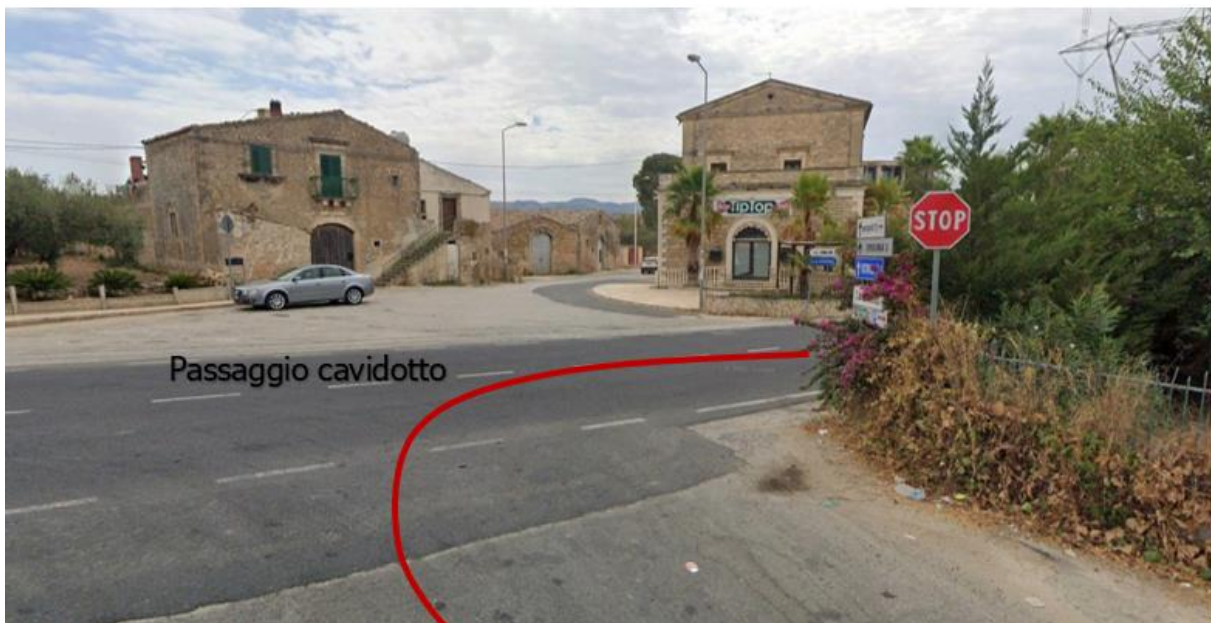
Figura 6-63 - Vista 5 passaggio cavidotto
