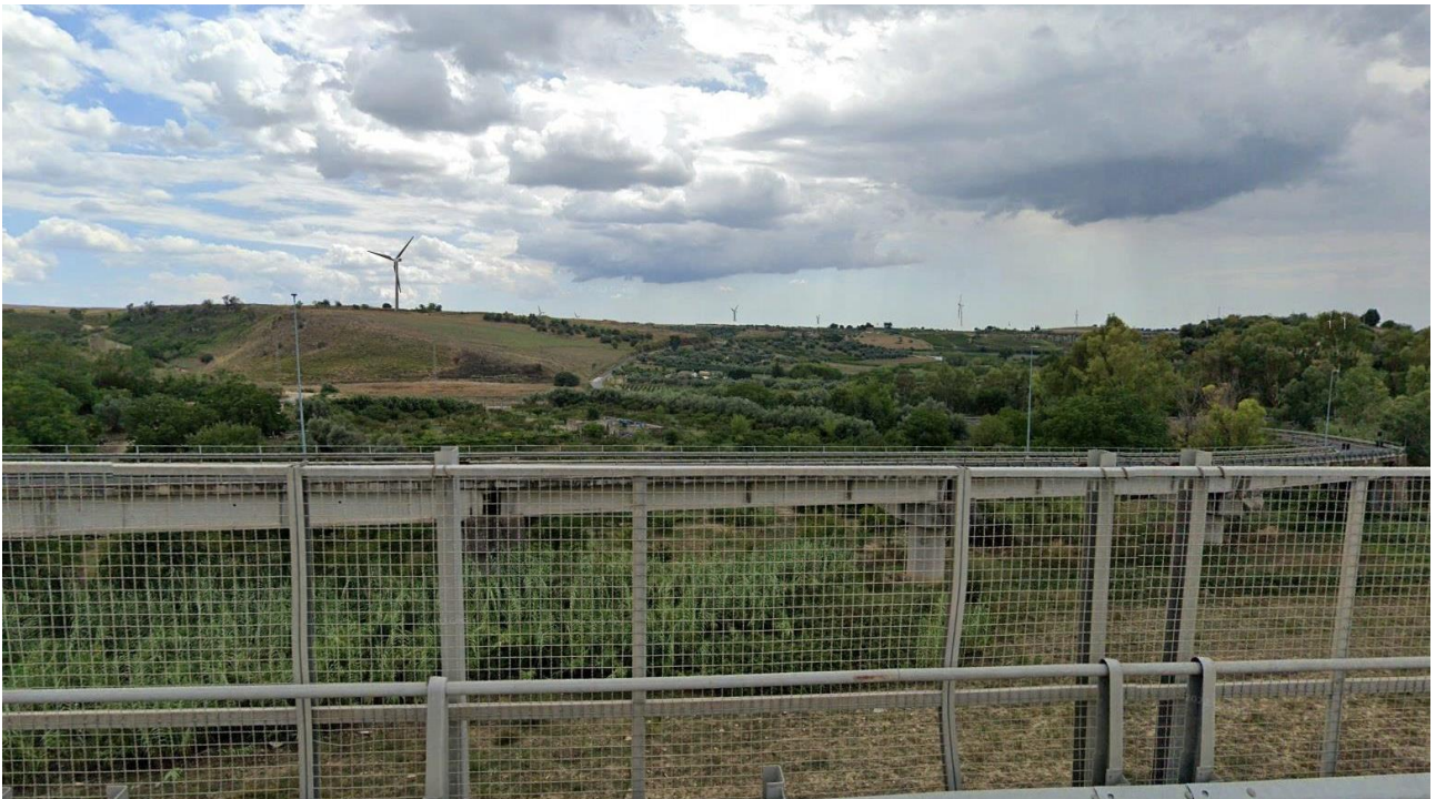
Figura 6-21 - Sopra vista ante operam, sotto vista post operam PO_01 da Viadotto Favarella nel Comune di Caltagirone
