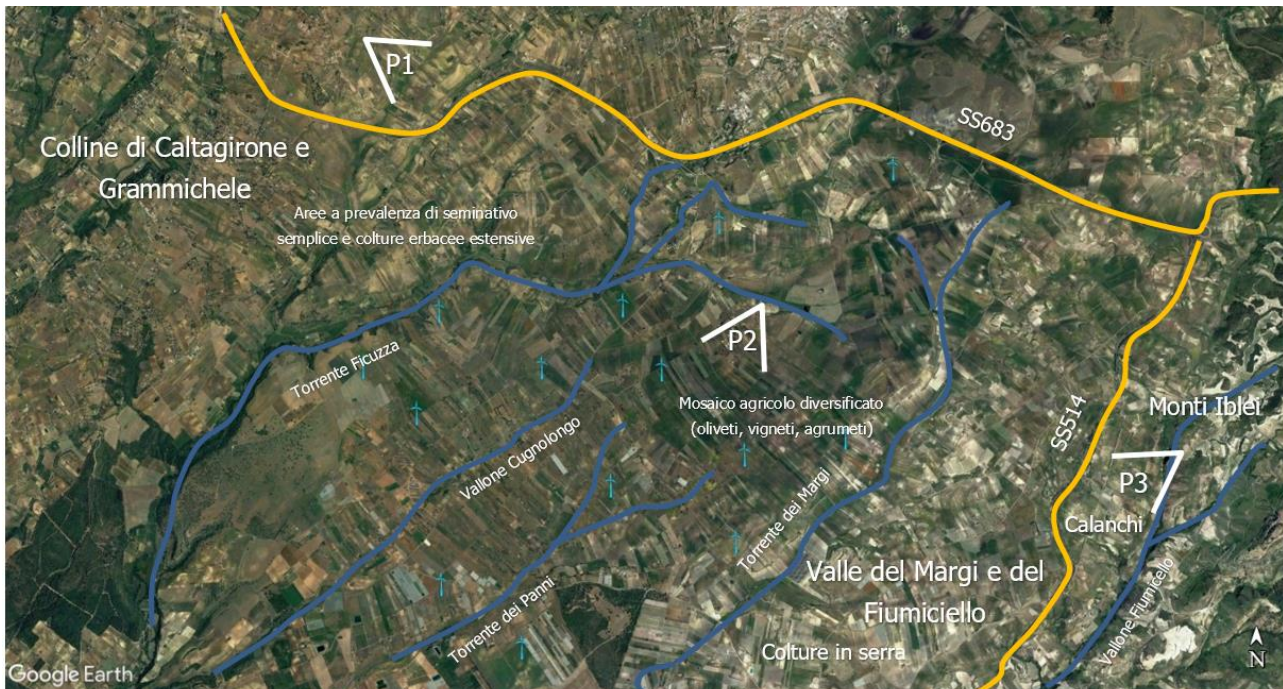
Figura 5-9 - Vista aerea generale dell'area di progetto nel territorio comunale di Caltagirone con indicazione elementi principali della struttura del paesaggio e punti di ripresa paesaggi locali P1, P2, P3.
